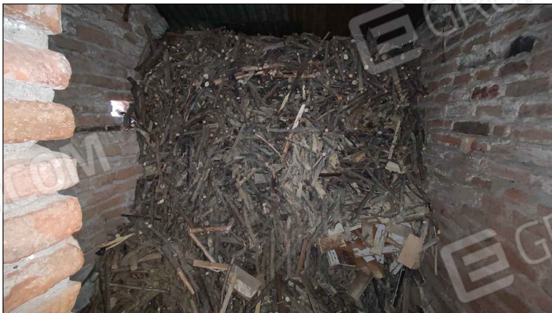
CORPO B (ripostiglio)
