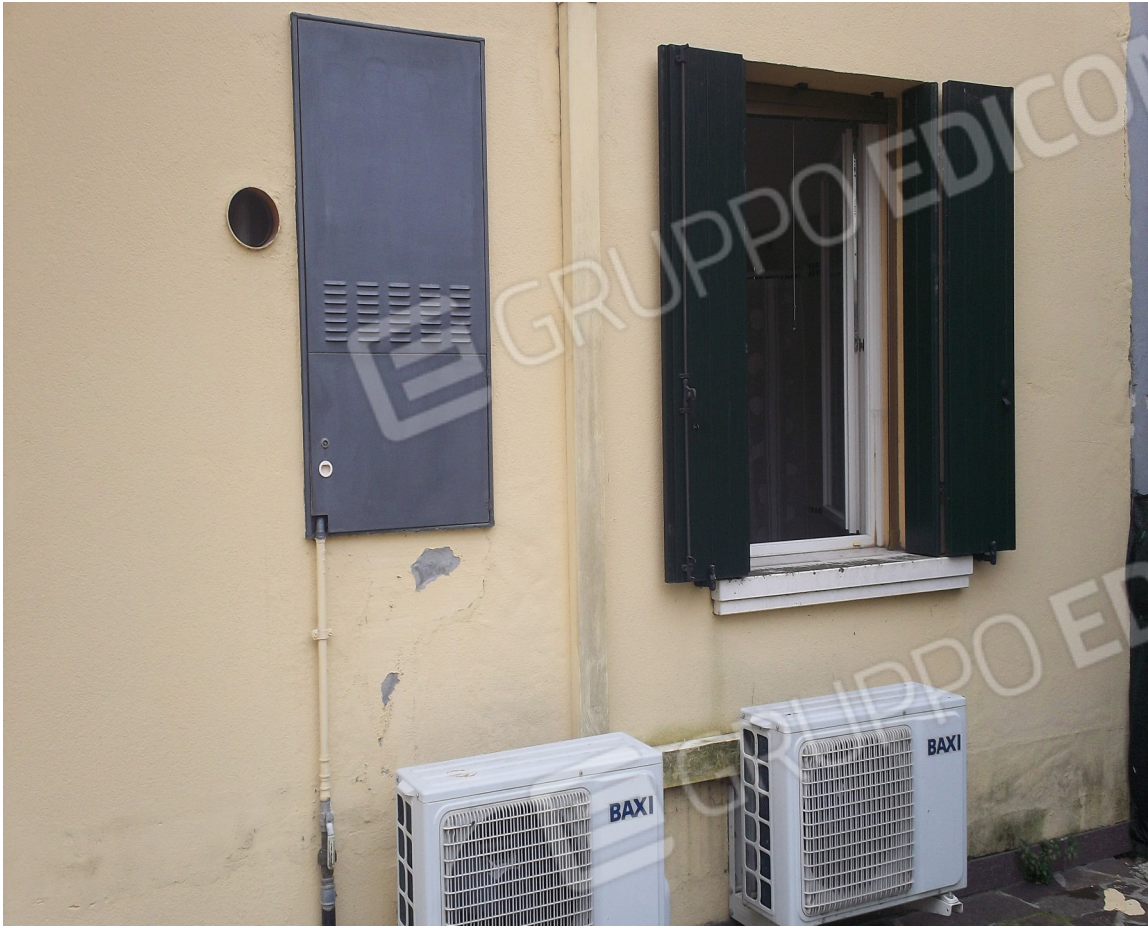
Vano Caldaia e Unità Esterne per condizionatori
