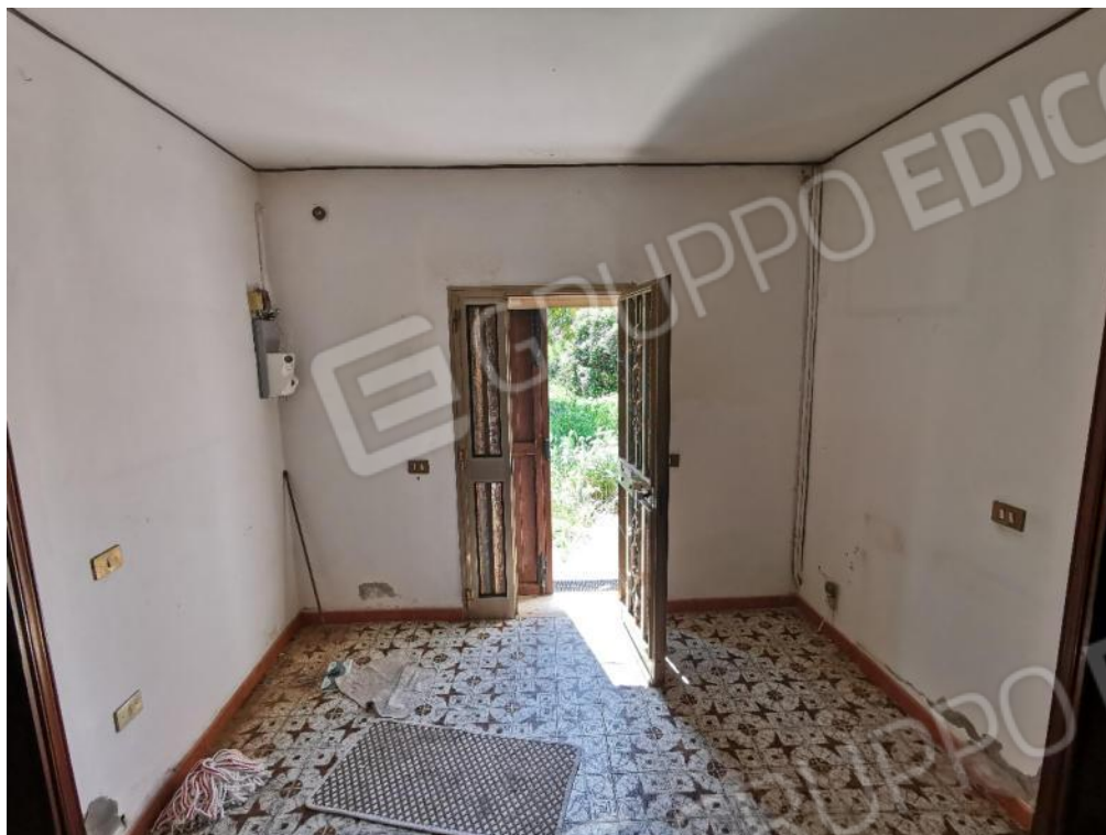
5 – particolare interno piano terra fabbricato principale
