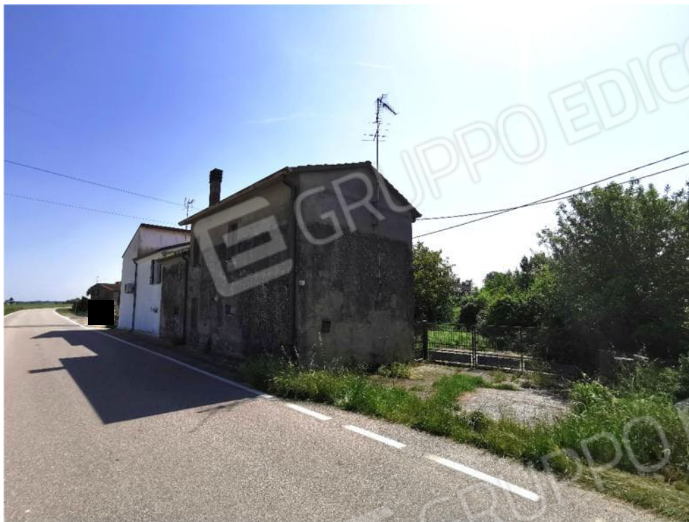
3 - prospetto nord – ovest fabbricato principale
