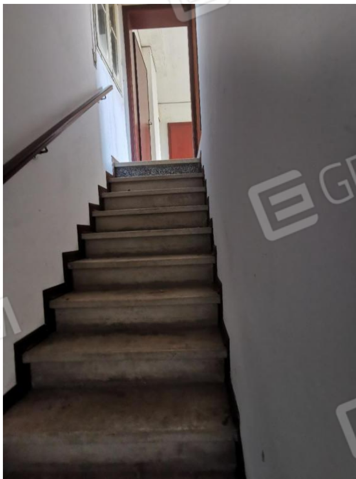
10 – particolare interno (vano scala) fabbricato principale
