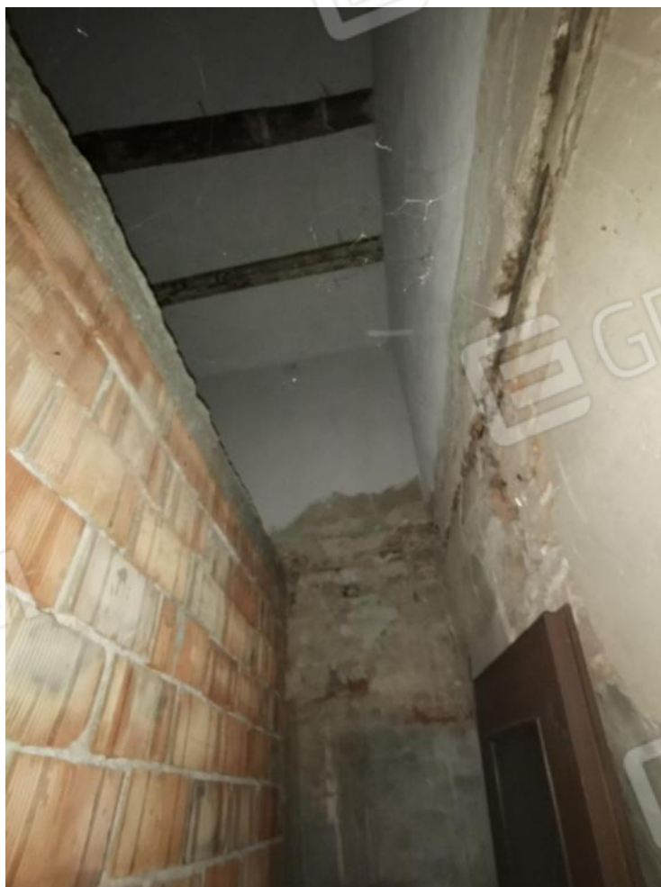
8 – particolare interno fabbricato principale
