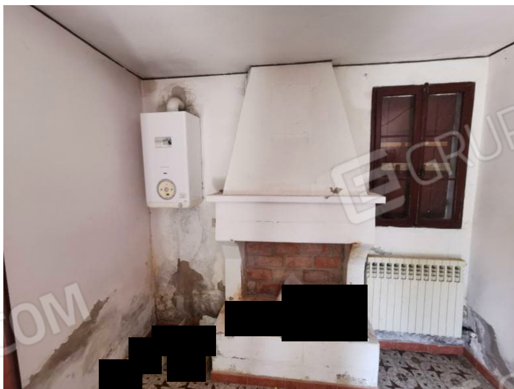
6 – particolare interno piano terra fabbricato principale
