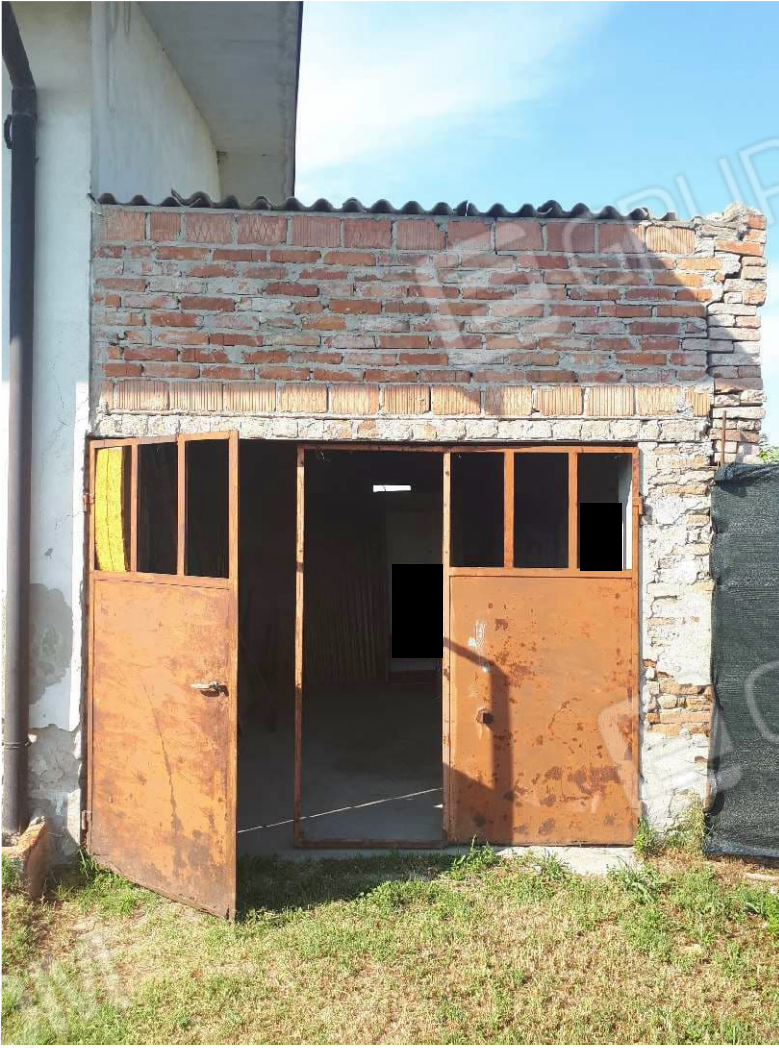
piccolo annesso dell'edificio da demolire
