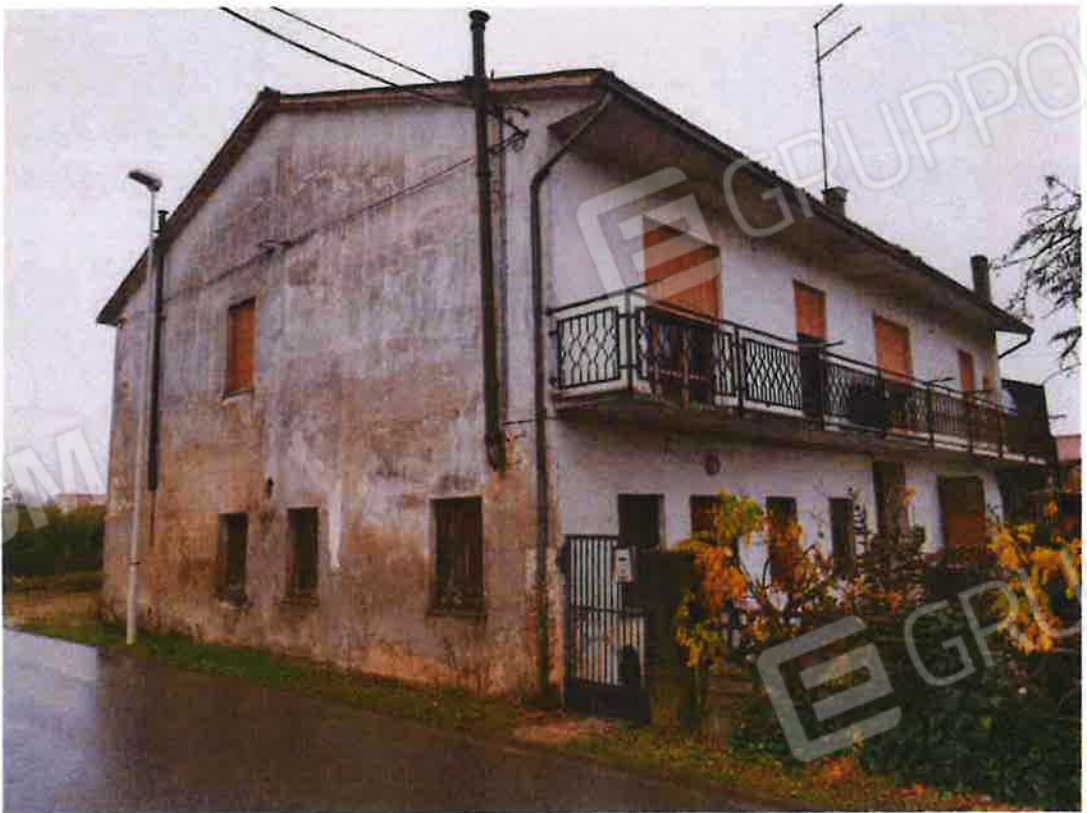
Vista sud-ovest fabbricato
