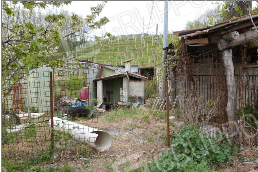
13 Vista da est del fabbricato sub 1 e, a destra, del piccolo fabbricato abusivo e della tettoia abusiva; sullo sfondo si vede parte del terreno tenuto a vigneto.
