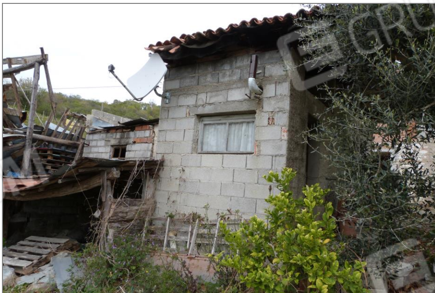
16 Vista da sud-est di parte del fabbricato sub 3.
