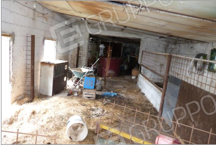
17 Parte dell'interno del fabbricato sub 2.
