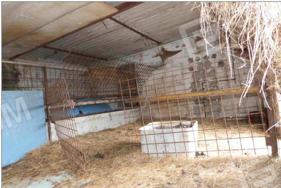
18 Altra parte dell'interno del fabbricato sub 2.
