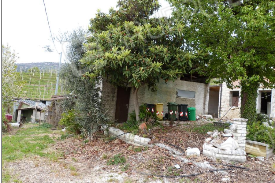
5 Vista da sud-est di parte dei fabbricati rurali e di parte dell'area scoperta.
