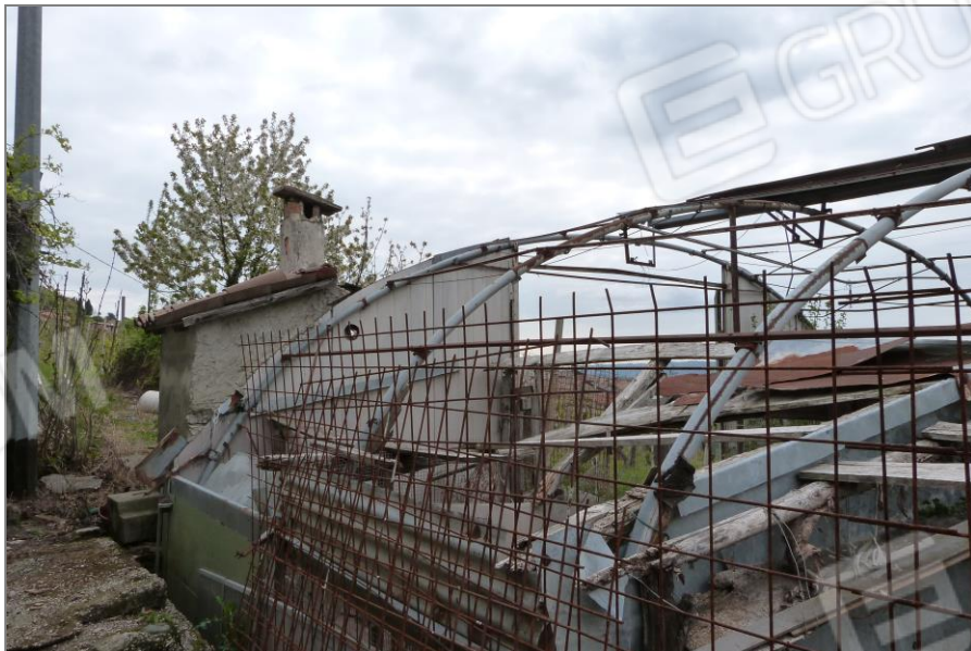
14 Vista da nord-ovest del fabbricato sub 1 (capannone a tunnel) e, dietro, il piccolo fabbricato abusivo.
