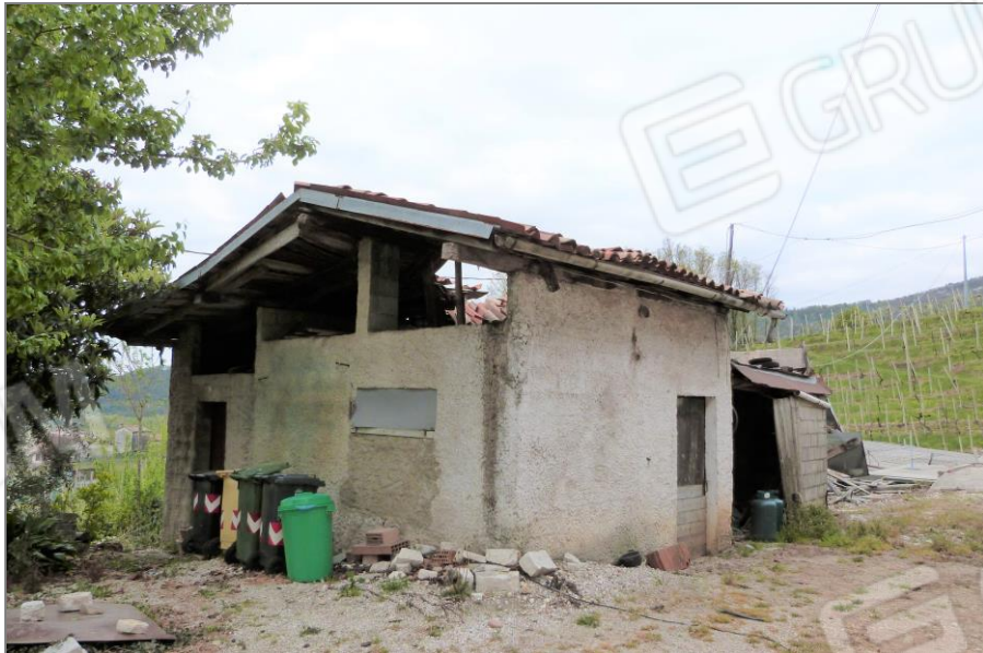
6 Vista dei prospetti est e nord del fabbricato sub 3.
