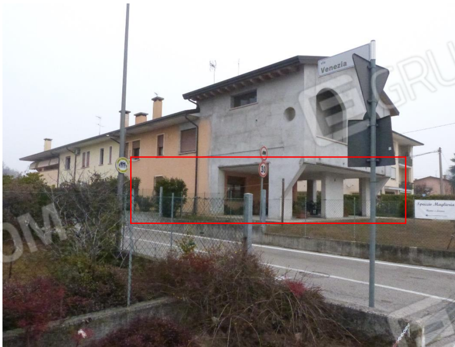
2 Vista del prospetto ovest e sud con parte dell'area scoperta.
