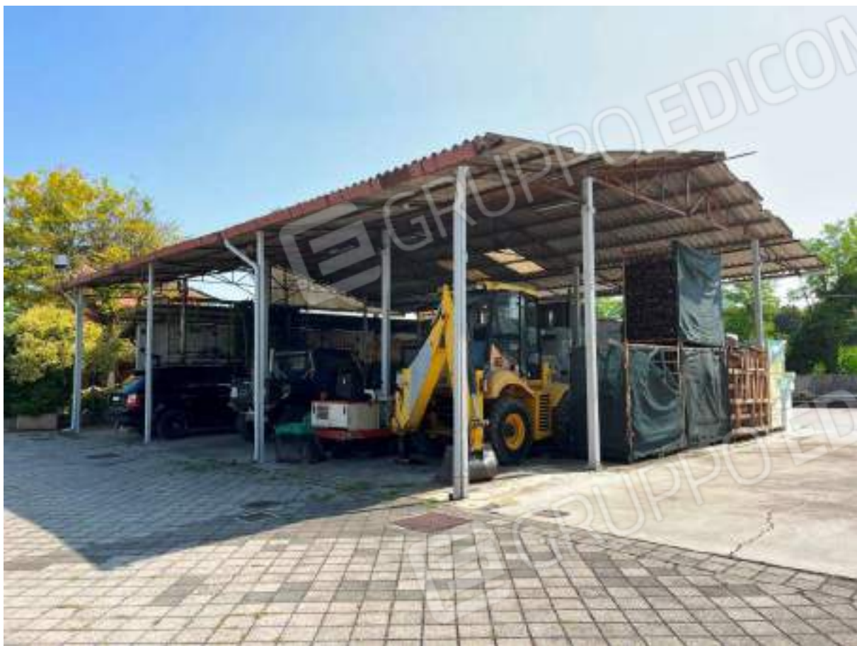
vista tettoia su piazzale
