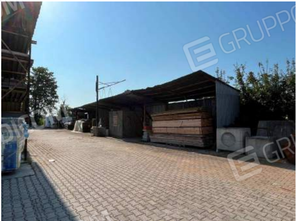
vista lato Sud
