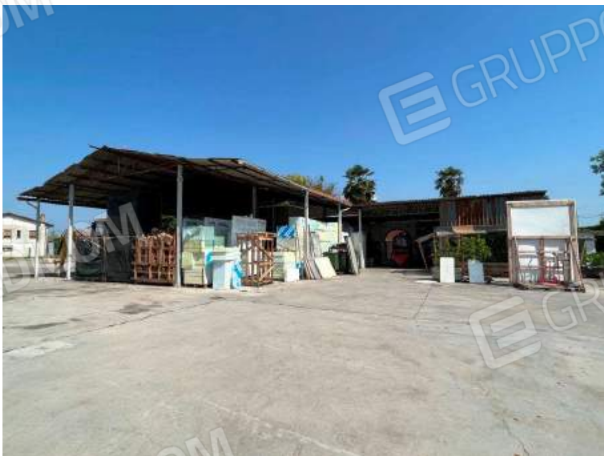
vista tettoia su piazzale
