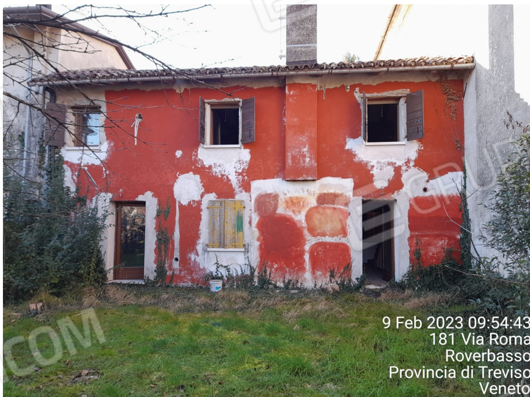
“IMMOBILE A” – vista nord dell’immobile
