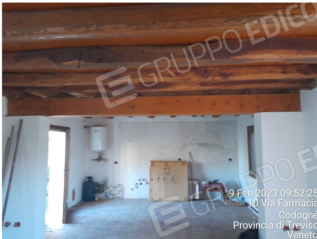
“IMMOBILE A” – vista verso est vano piano terra
