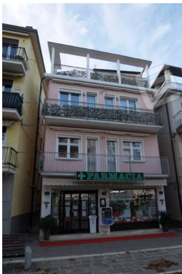
FOTO 1 - Il fabbricato in Via San Marco 629.
