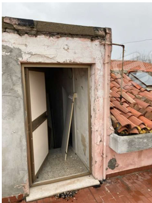
FOTO 13 - L'accesso alla terrazza.
