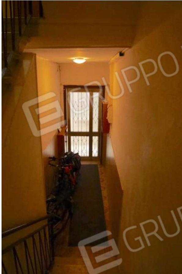
FOTO 4 - Interno. L'ingresso comune.
