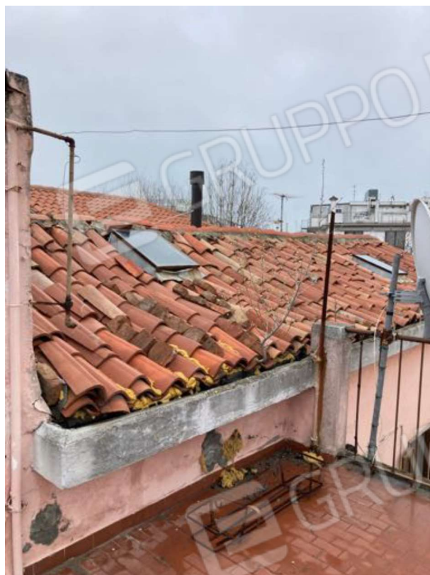
FOTO 12 - La copertura e la terrazza.
