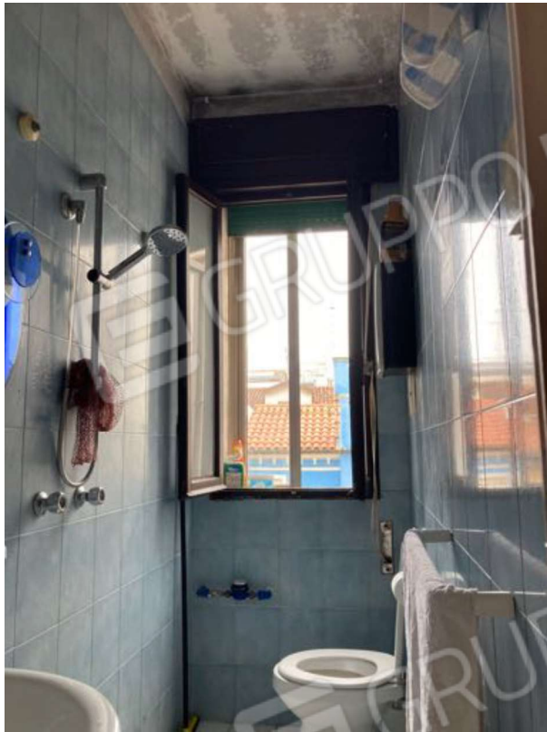
FOTO 10 - Unità al piano terzo. Il bagno.
