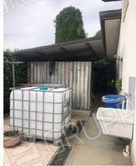
Vista Tettoia Lato Ovest
