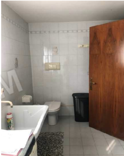
Vista lavanderia P.T.
