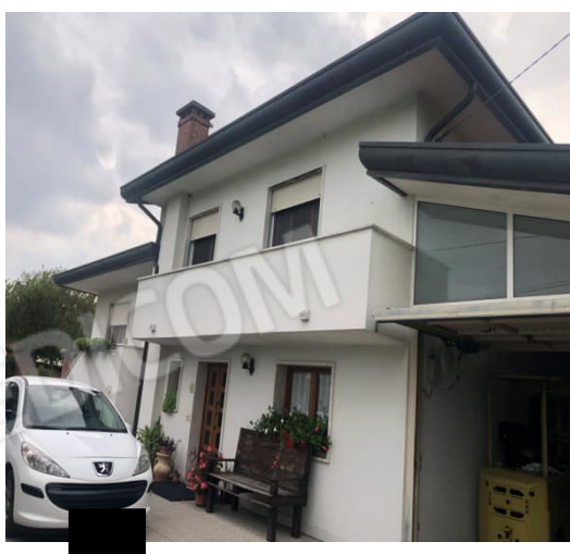
Prospetto EST con vista sul garage
