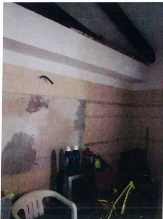
Foto 9 - Vista locale pluriuso
