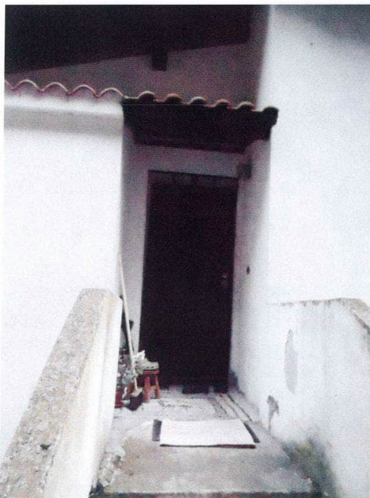
Foto 4 – Vista pianerottolo e porta d'accesso
