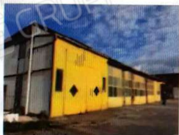
Fig. 24. Esterno fabbricato abusivo – vista ovest
