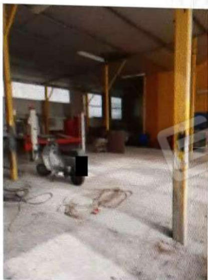
Fig. 27. Interno fabbricato abusivo - locale lavorazione 1
