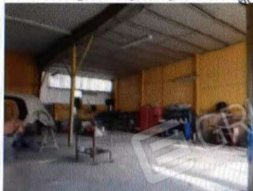
Fig. 32. Interno fabbricato abusivo - locale lavorazione 2
