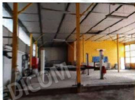
Fig. 25. Interno fabbricato abusivo - locale lavorazione 1
