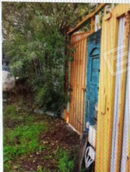
Fig. 39. Ingresso pedonale – vista interna
