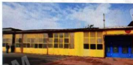
Fig. 23. Esterno fabbricato abusivo – vista sud
