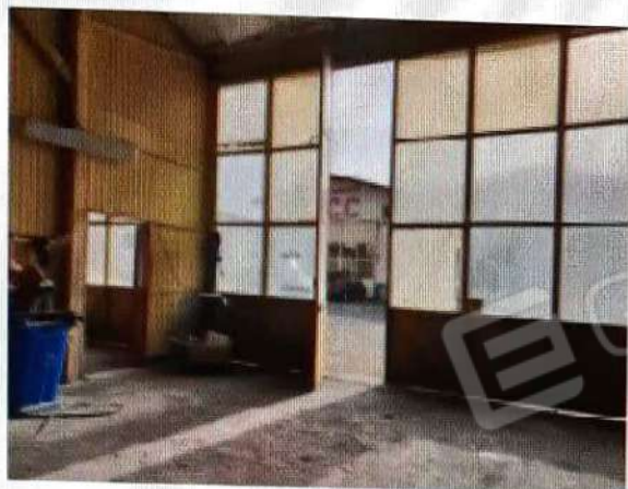
Fig. 33. Interno fabbricato abusivo - locale lavorazione 2
