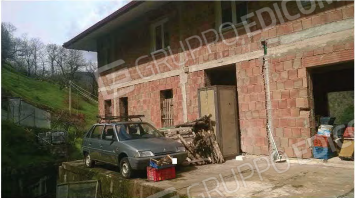
parte posteriore del fabbricato (priva di finitura esterna)
