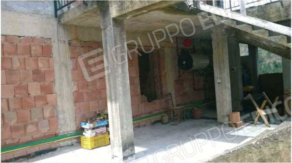
Scale di accesso in c.a. al piano terzo, destinato a residenza
