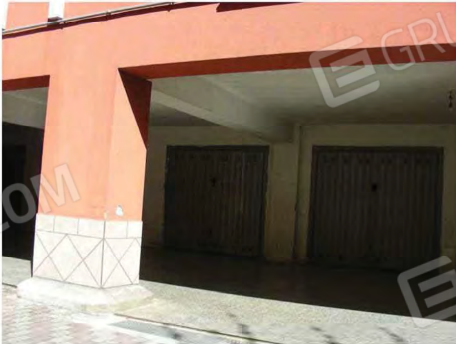
Foto 18 - Veduta della zona garages al piano seminterrato
