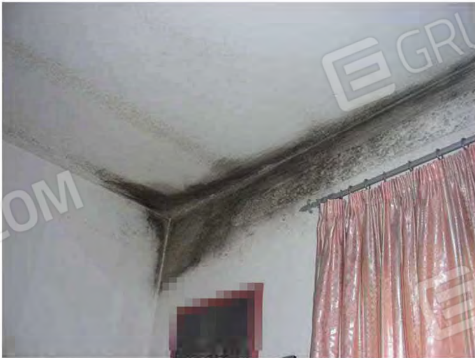
Foto 16 - Veduta sui fenomeni di condensa
