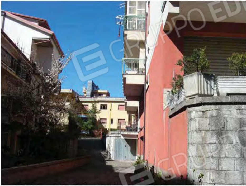
Foto 05 - Veduta della corte interna livello garage (lato ovest)
