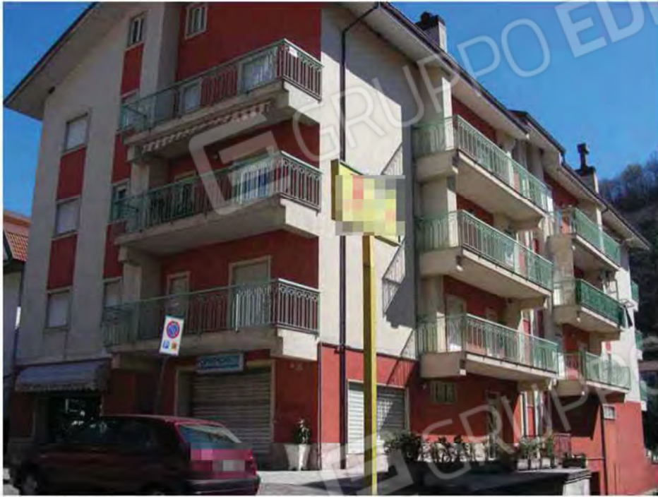
Foto 01 – Veduta d'insieme del fabbricato dalla strada comunale (da nord)
