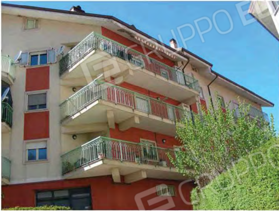
Foto 03 - Veduta d'insieme del fabbricato dalla corte interna (da sud)
