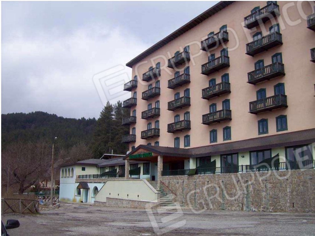
Foto 1 – Ingresso alla struttura
