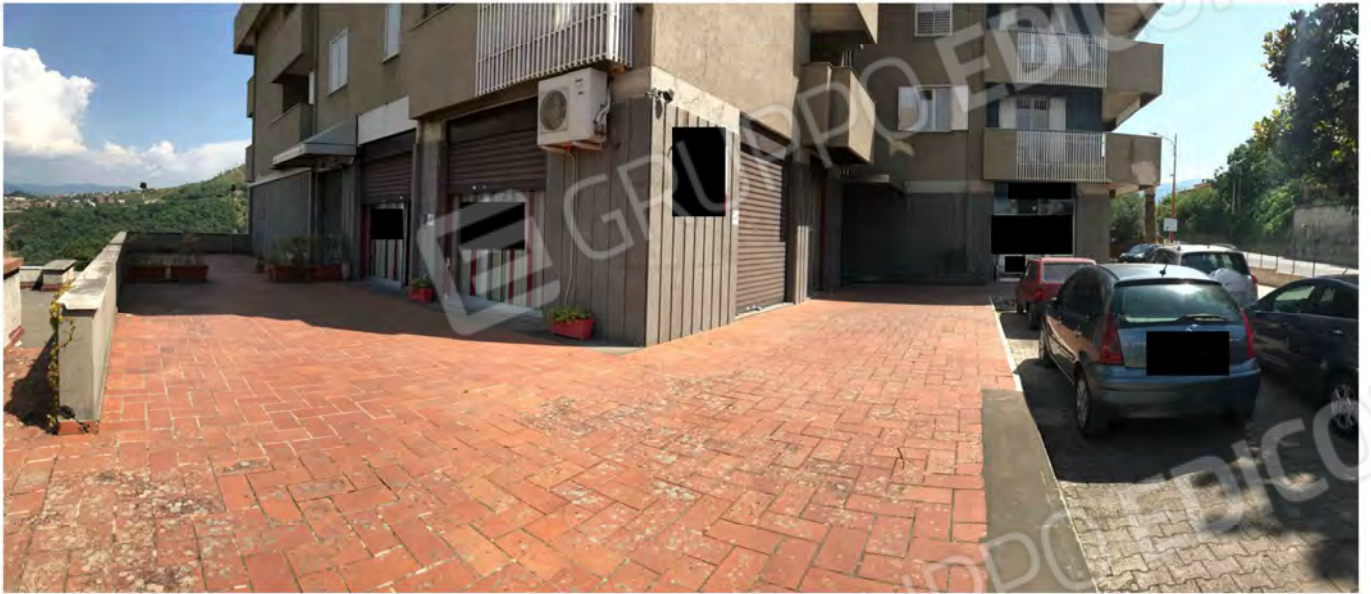
Foto 8 – Panoramica esterna Immobile 1 e Immobile 2
