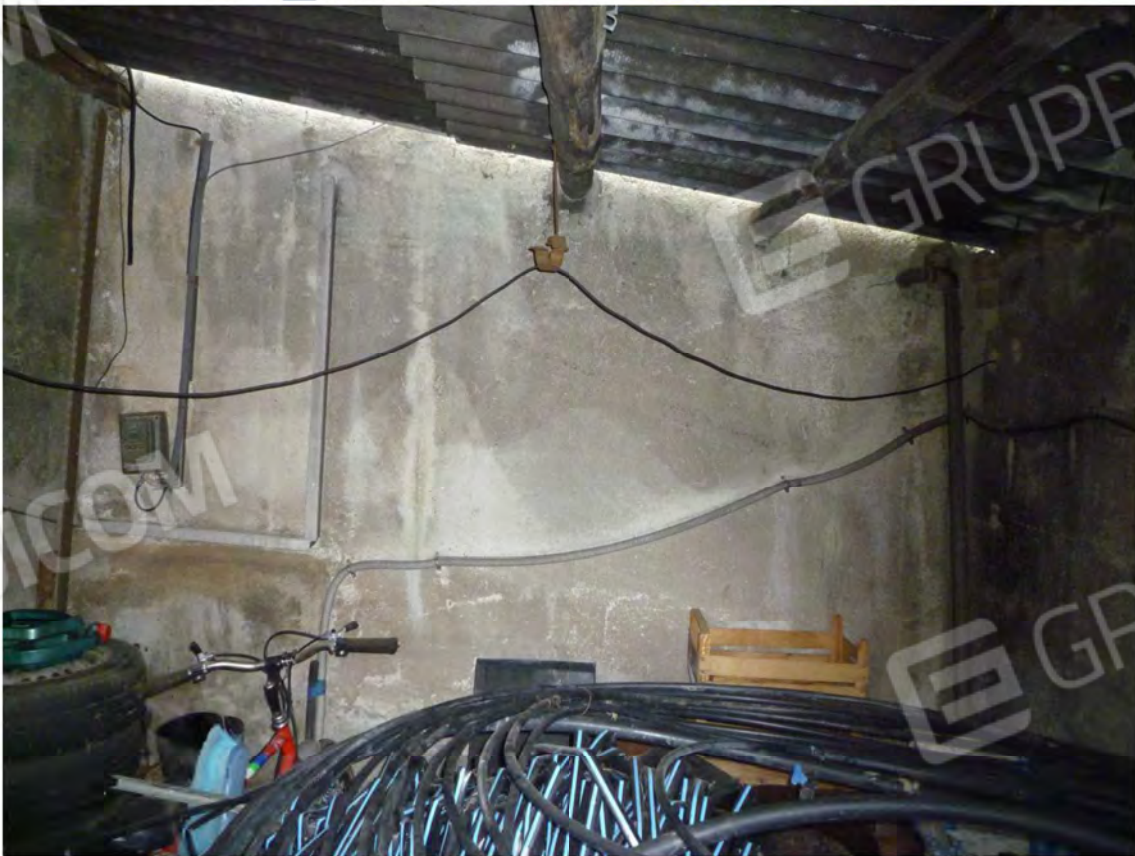
FOTO 57 – 58 locali accessori 1e2 interno 2
