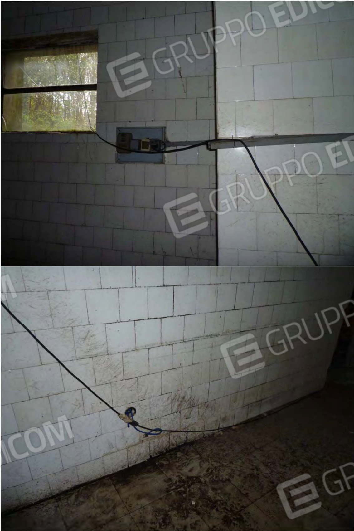
FOTO 30-31 fili elettrici aerei sala lavorazione 3
