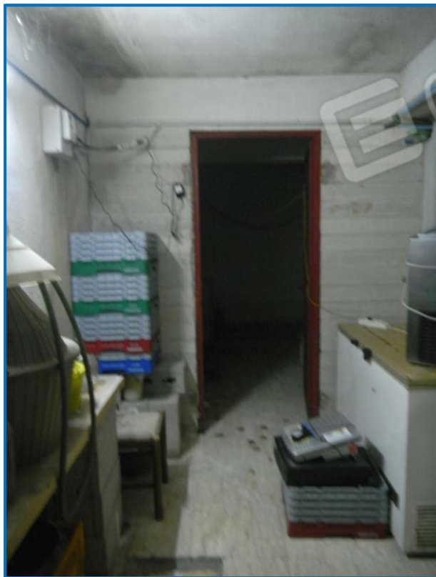
Foto n° 17 – magazzino piano terra con ingresso dal 1° piano
