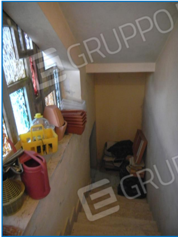
Foto n° 16 – magazzino piano terra con ingresso dal 1° piano
