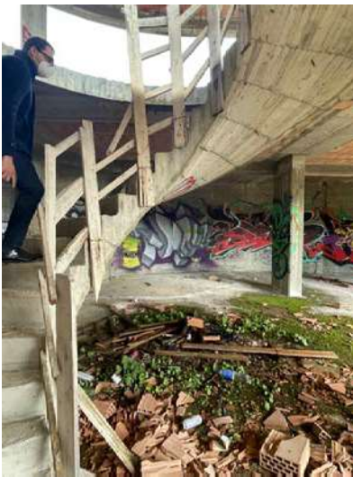
INTERNO – SCALA CORPO A
