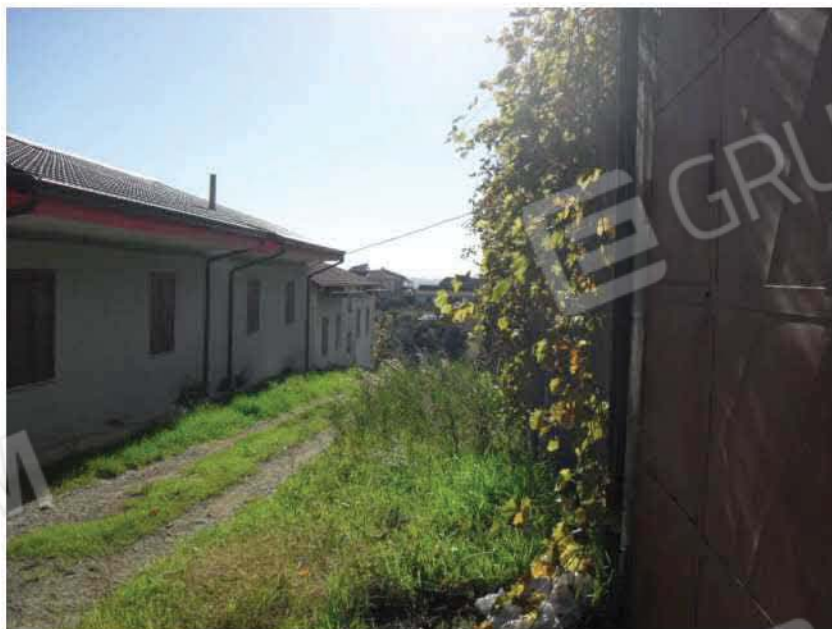
Foto N.24: Vista terreno par.lla 734 in fondo a Sx
