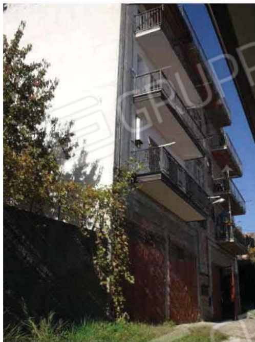
Foto N.23: ingressi ai magazzini da Via Misasi
