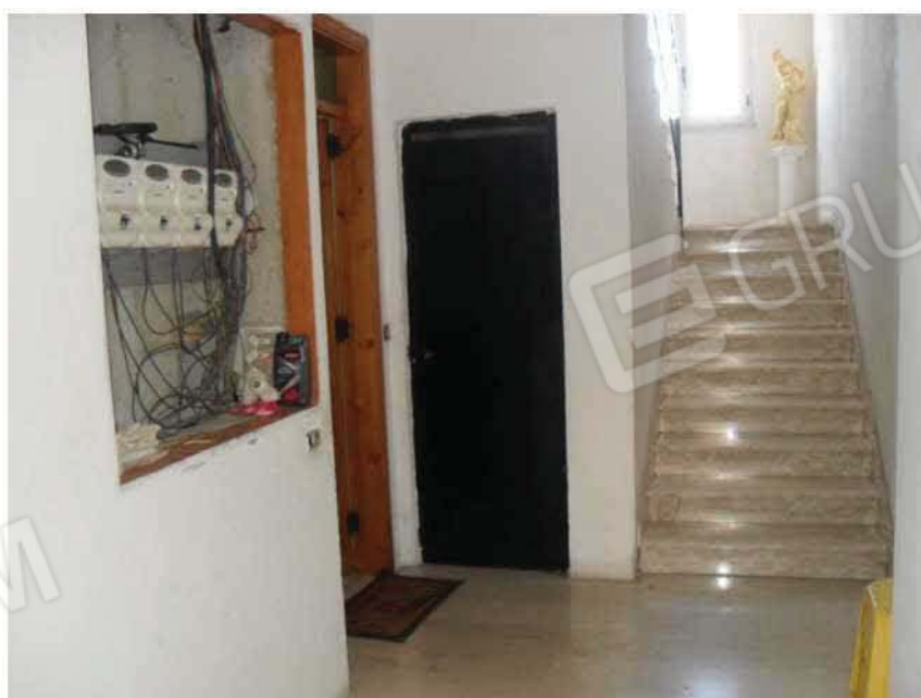
Foto N. 4: Atrio edif, ingresso appart. PT sub 1 e PS sub 9
