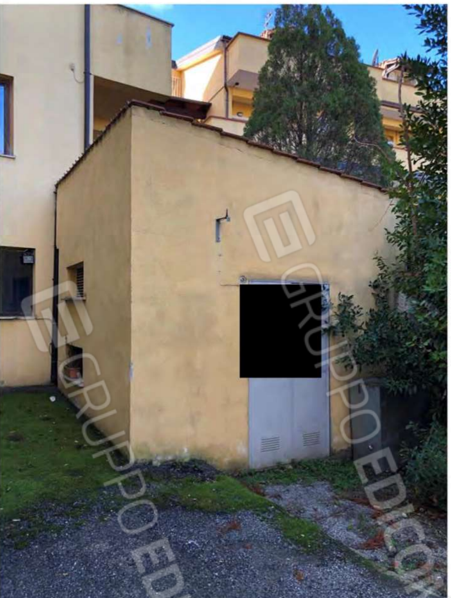
Foto 15 - Cabina elettrica, fig.12, p.lla 633, sub.2.
