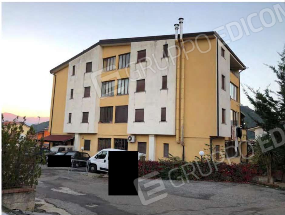
Foto 17 - Fabbricato Mendicino, fg.12, p.lla 634.
