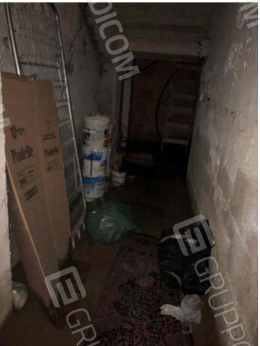
Foto 16 - Cantina sottoscala, fig.12, p.lla 634, sub.17.
