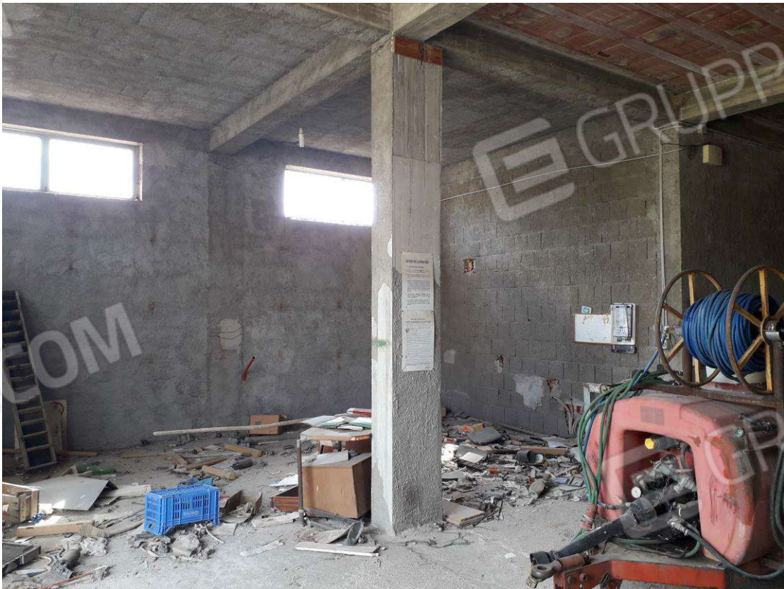
Foto N.19: Sub 5 locali magazzini in corso di costruzione
