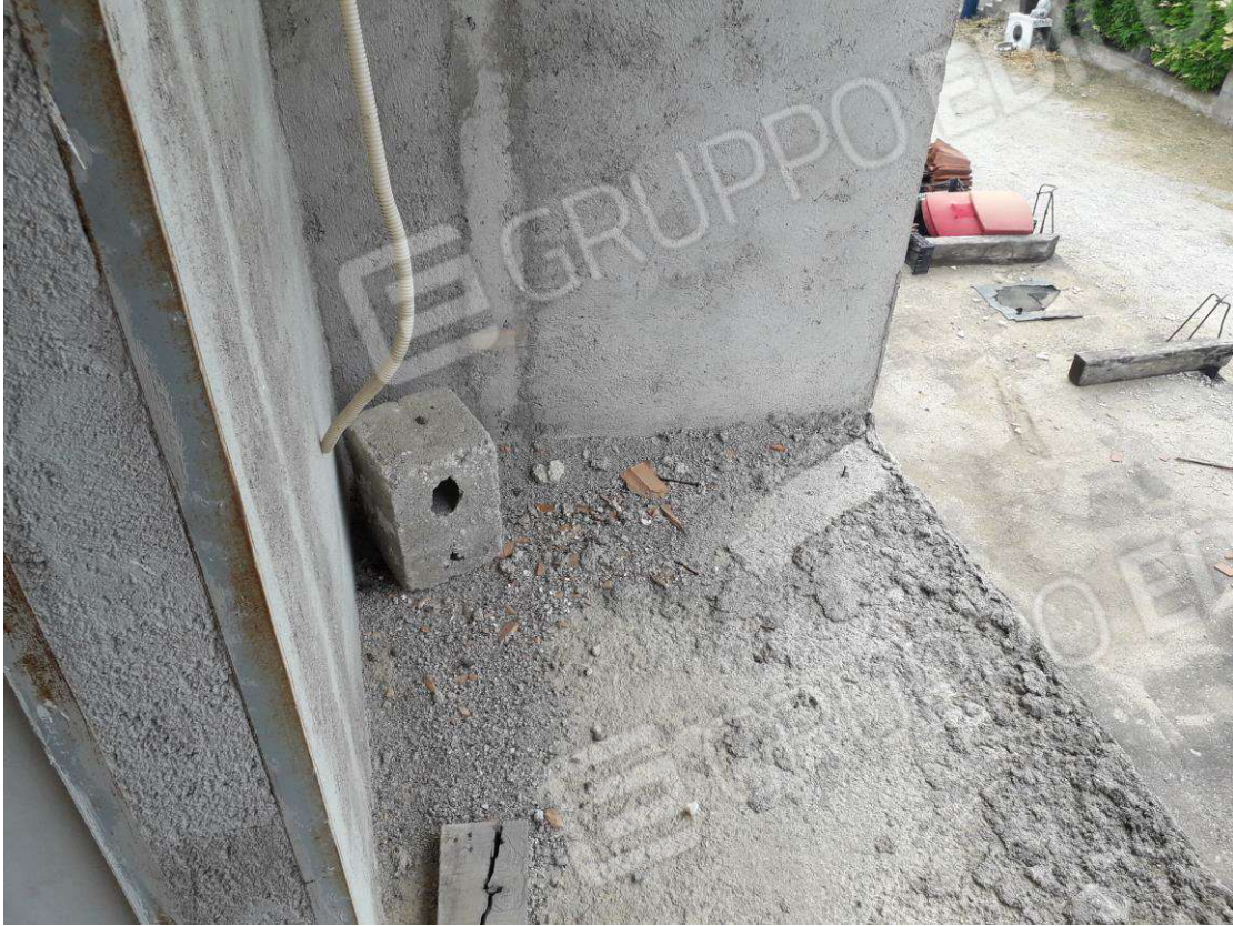
Foto N.13: immobile oggetto di stima sub 3 in corso di costruzione - balcone
