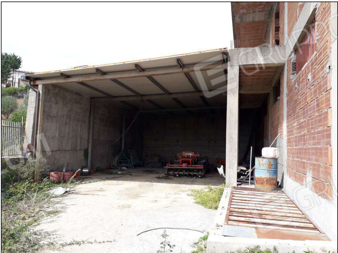
Foto N.4: Prospetto Ovest dell'immobile oggetto di stima con tettoia in metallo da demolire
