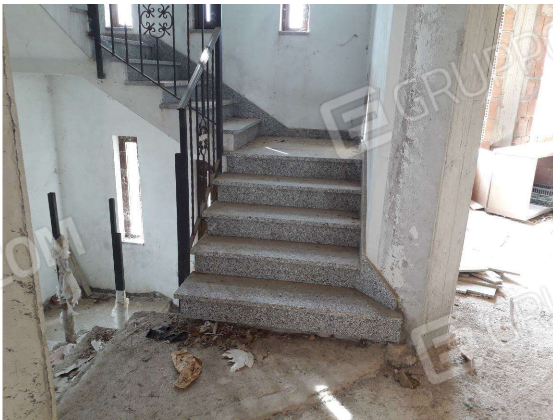
Foto N.6: Corpo scala sub 6
