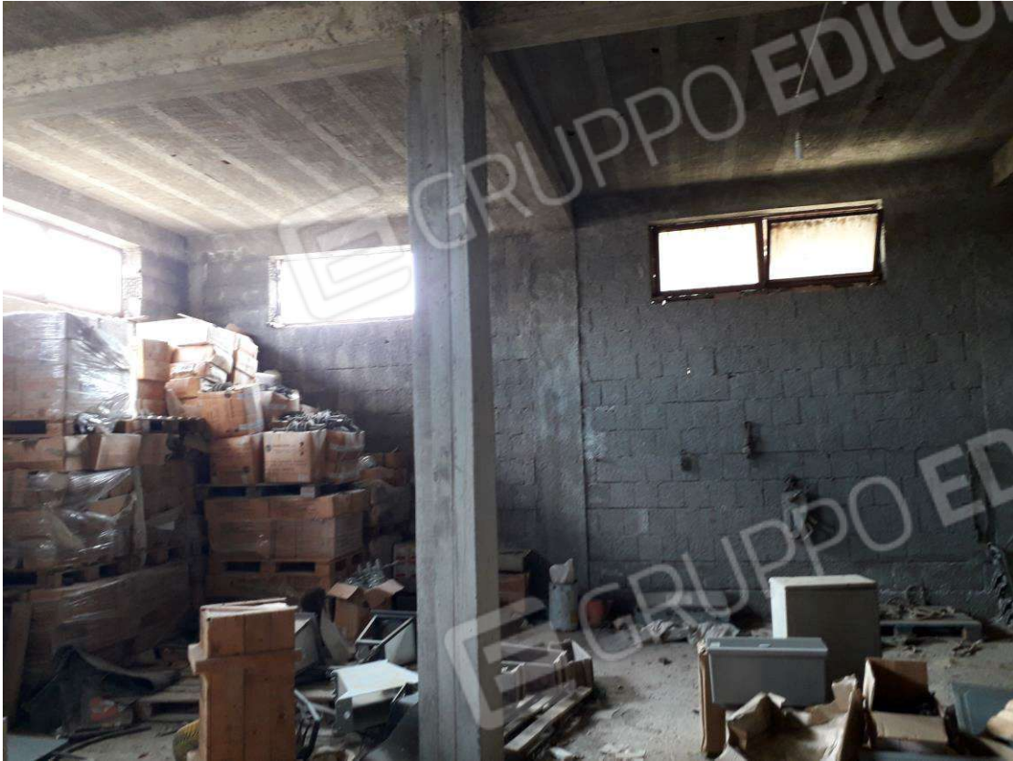
Foto N.22: Sub 5 locali magazzini in corso di costruzione
