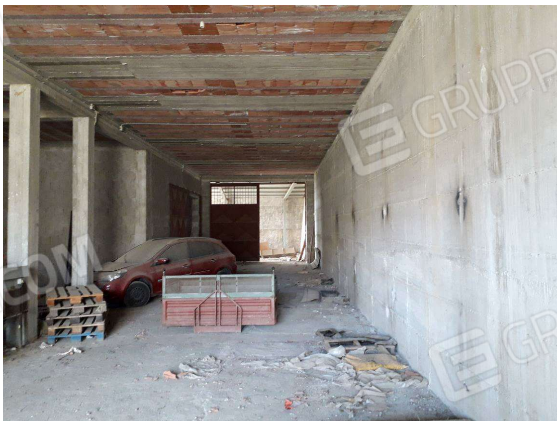
Foto N.21: Sub 5 locali magazzini in corso di costruzione
