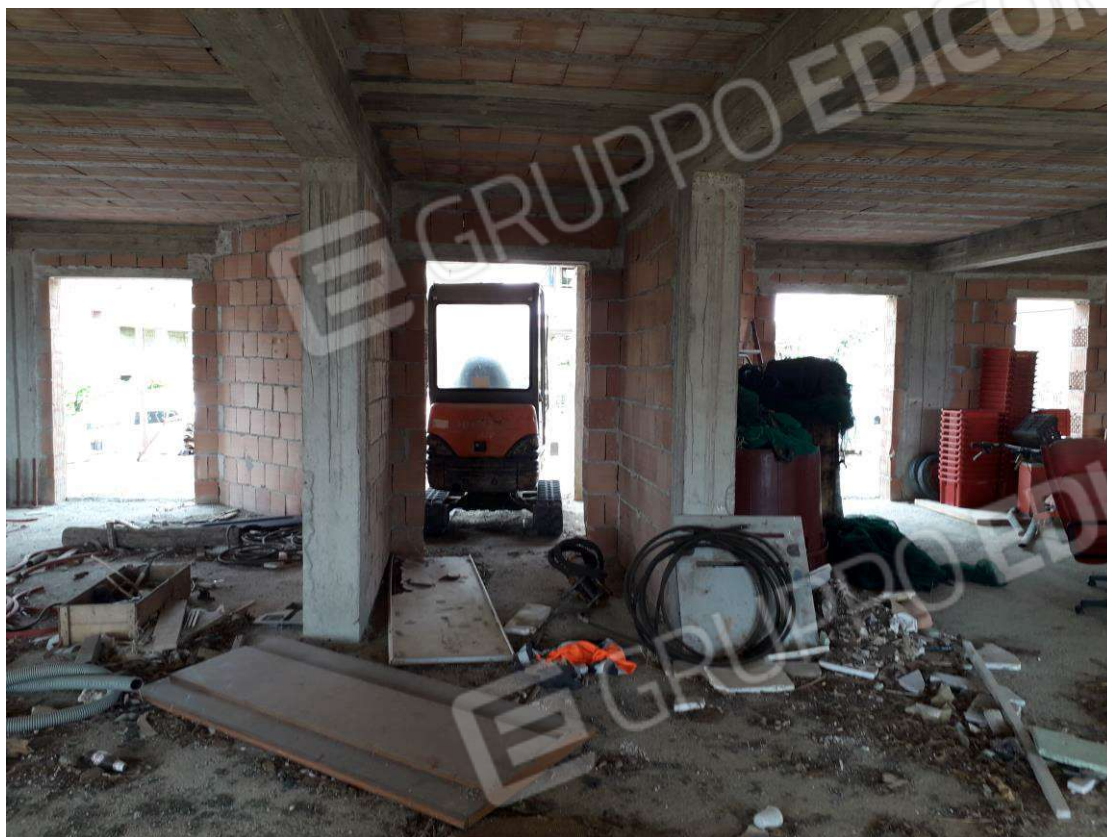
Foto N.5: Ingresso dell'immobile oggetto di stima con a destra sub 1 e a sinistra sub 2
