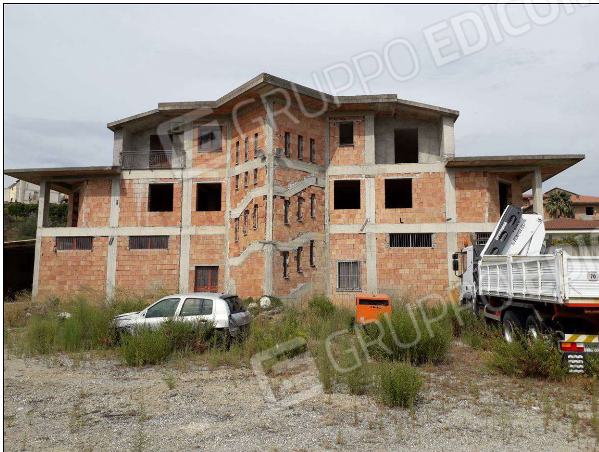
Foto N.1: Prospetto Sud dell'immobile oggetto di stima.
