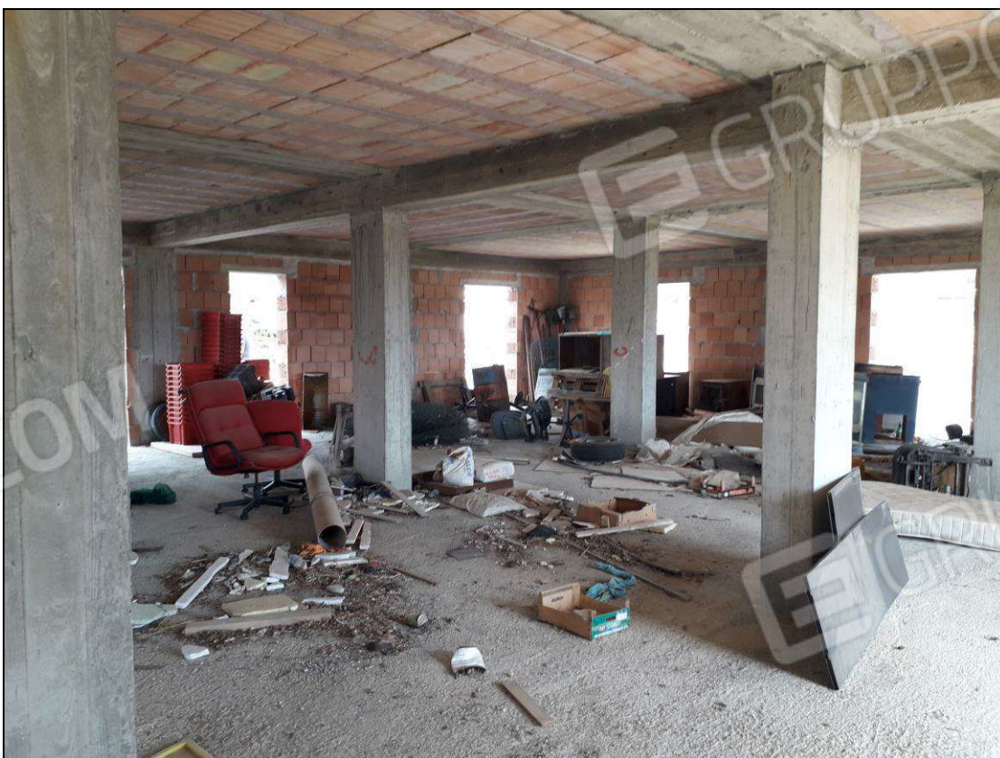
Foto N.8: immobile oggetto di stima sub 2
