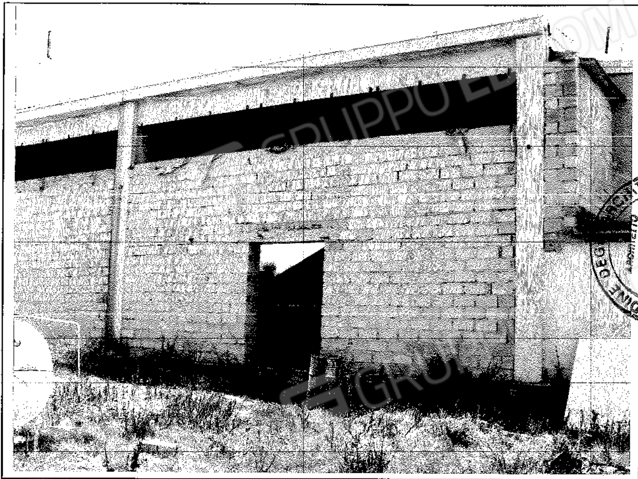
Foto n. 25 - Azienda agricola in Bisignano, c.da Franci, capannone.
