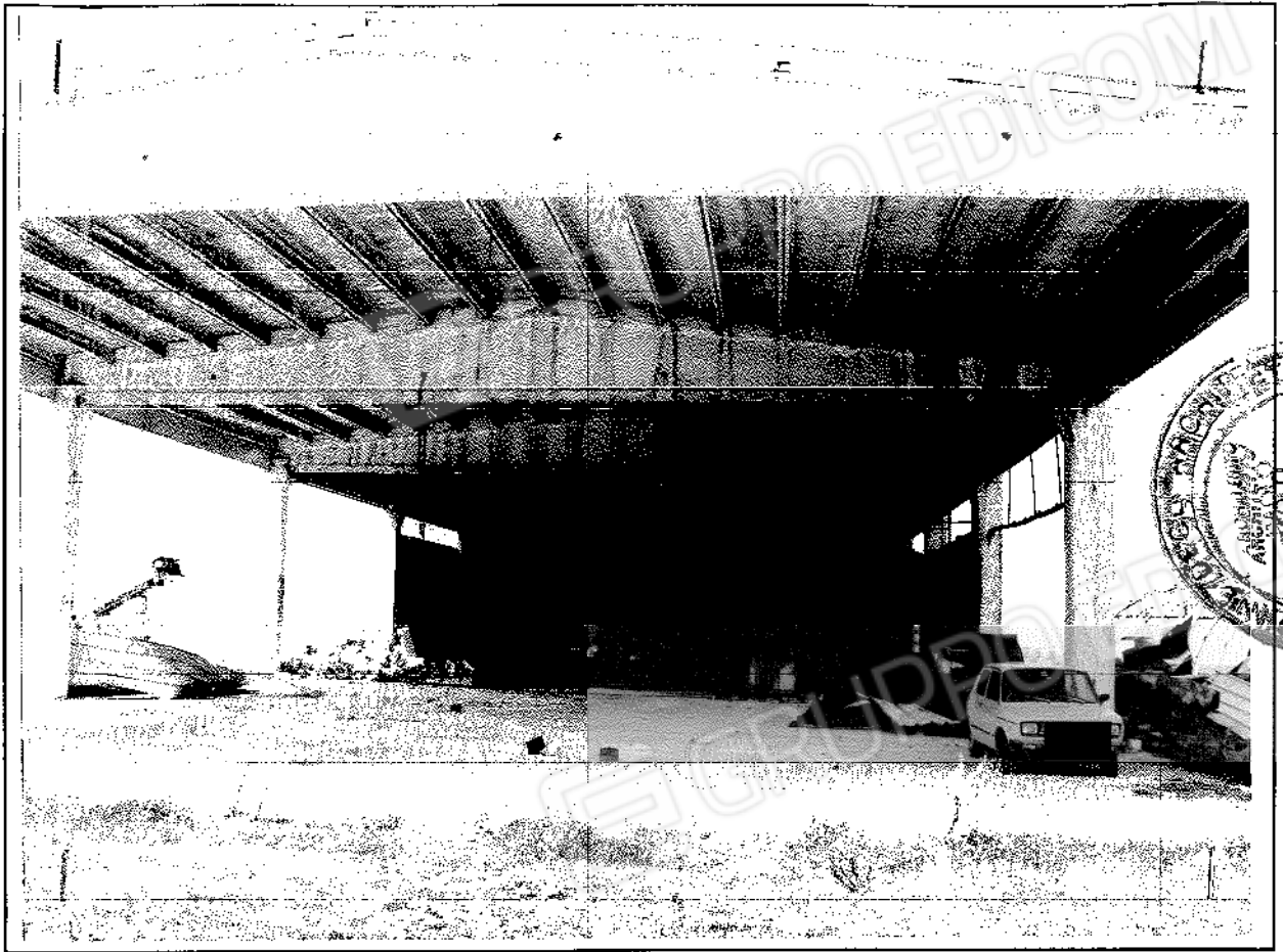
Foto n. 21 - Azienda agricola in Bisignano, c.da Franci, capannone.
