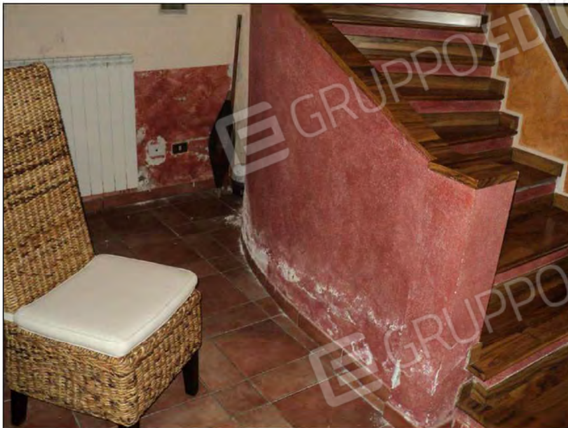
Foto NN.11,12: Macchie di umidità al piano seminterrato.
