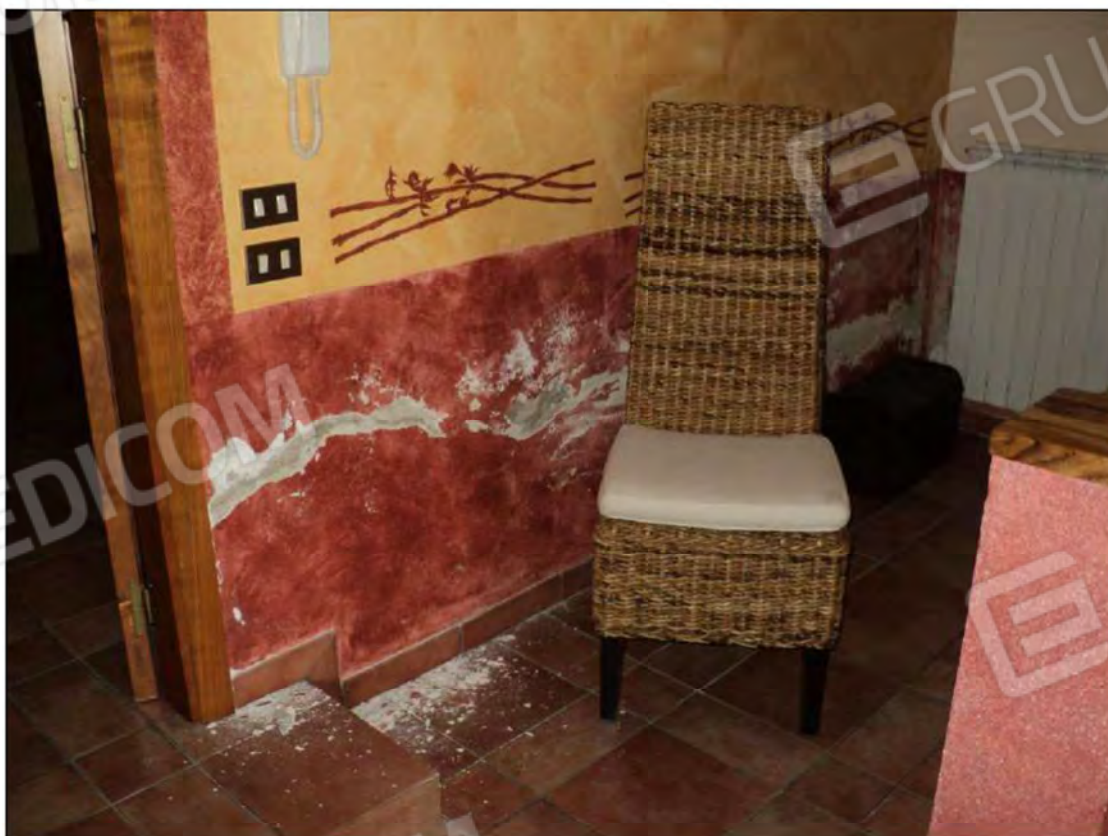
Foto NN.11,12: Macchie di umidità al piano seminterrato.
