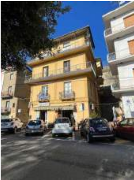
3: prospetto su viale Roma
