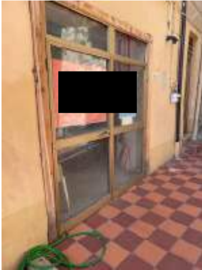
19: ingresso magazzino – piano terra
