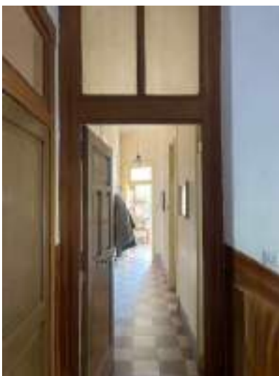
7: ingresso e corridoio – dx corpo scale
