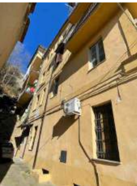
5:prospetto nord - ingresso fabbricato
