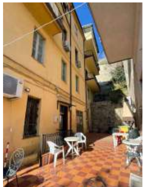
6: prospetto sud – ingresso magazzino
