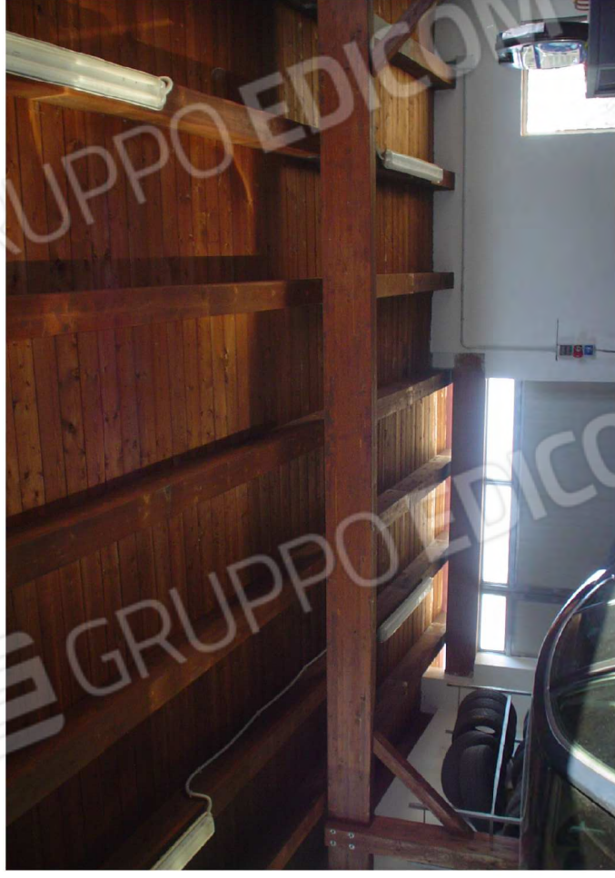
Interno: particolare copertura in legno lamellare
