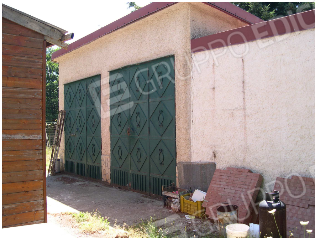
Foto 33 – Deposito-garage censito al foglio 4 part.IIa n. 124
