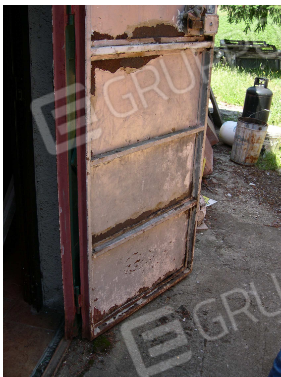
Foto 37 – Deposito-garage censito al foglio 4 part.IIa n. 124: porta esterna.
