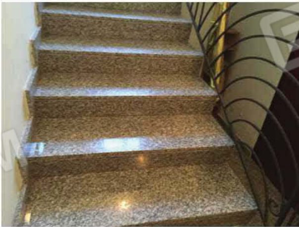
Foto 13: rampa scale (pt) – particolare del gradino
