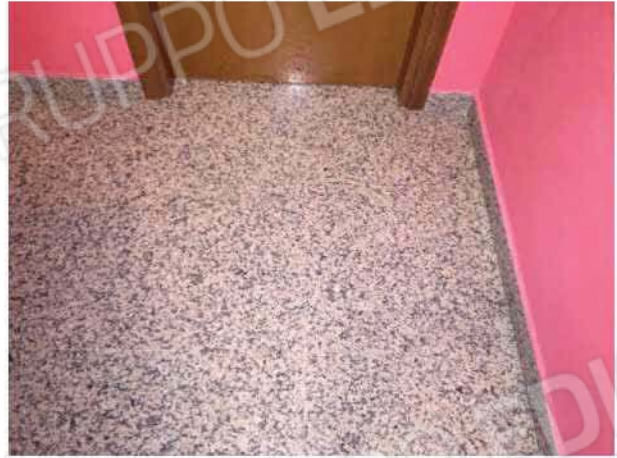
Foto 26: disimpegno - caratteristiche pavimentazione (p1)
