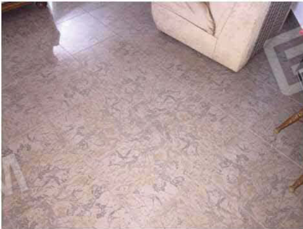
Foto 21: salone-soggiorno (p1) – pavimentazione
