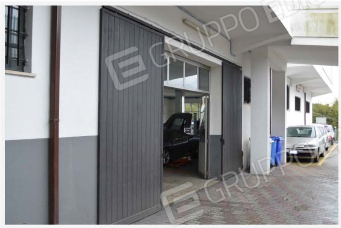
3 - Particolare del lato ovest, piano terra
