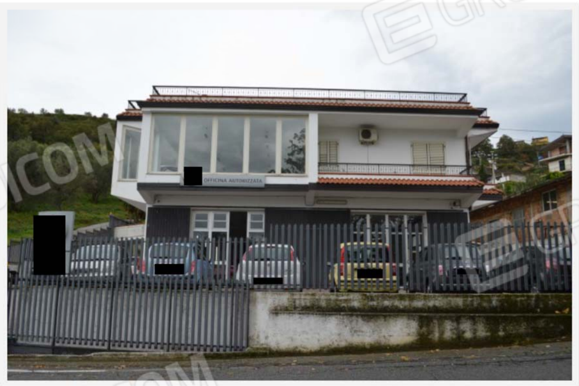
2 - Vista dell'edificio, lato sud
