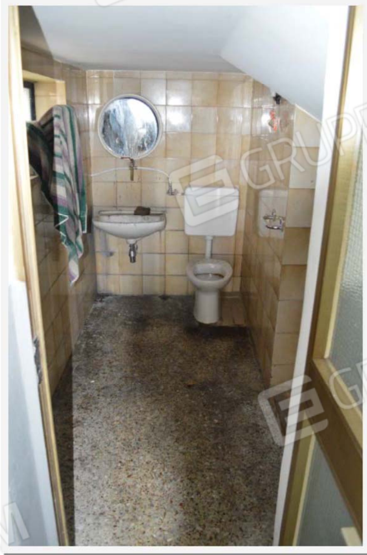
10 - particolare del pavimento in mattonelle di graniglia
