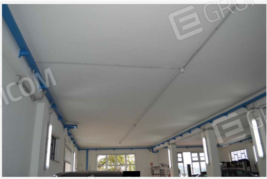
8 - Particolare del soffitto, sub. 3
