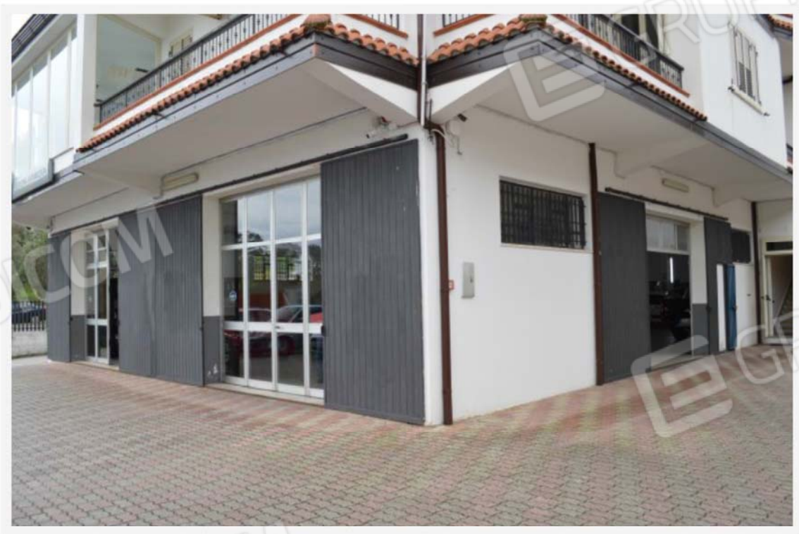
4 - Vista dell'angolo sud-est
