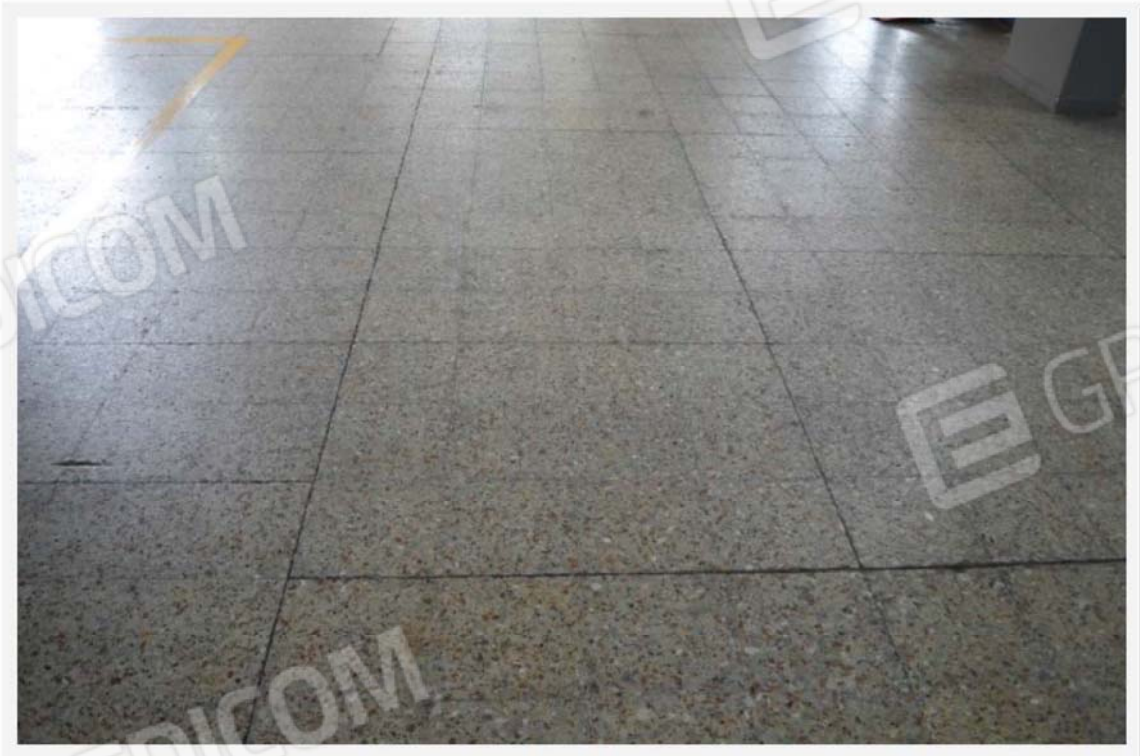
10 - particolare del pavimento in mattonelle di graniglia
