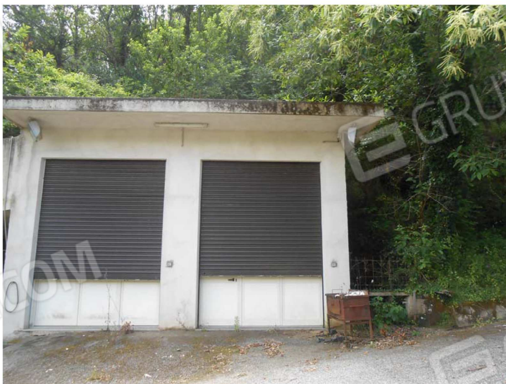
Foto n. 14: prospettiva fabbricato individuato dalla particella 534, foglio di mappa 34, del comune di Filadelfia.
