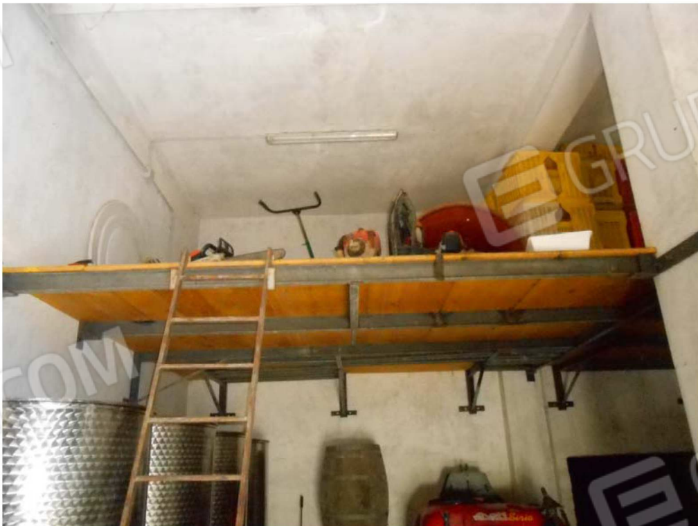
Foto n. 16: prospettiva ambiente "A" e soppalco "S" – fabbricato individuato dalla particella 534, foglio di mappa 34, del comune di Filadelfia.
