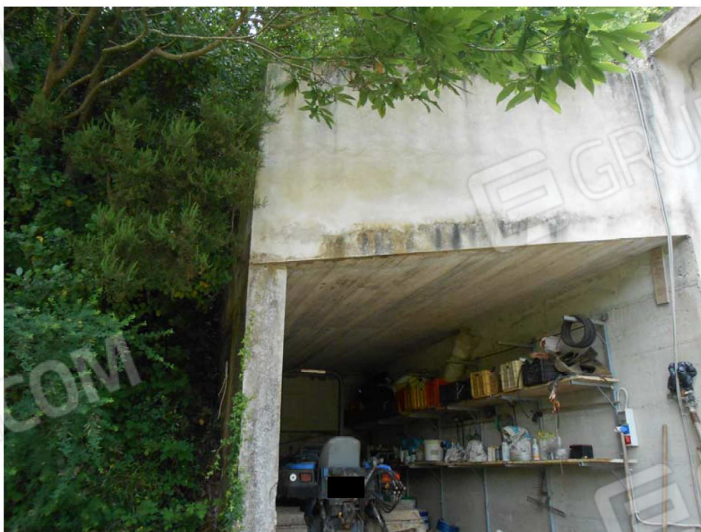
Foto n. 18: prospettiva ambiente “B” – fabbricato individuato dalla particella 534, foglio di mappa 34, del comune di Filadelfia
