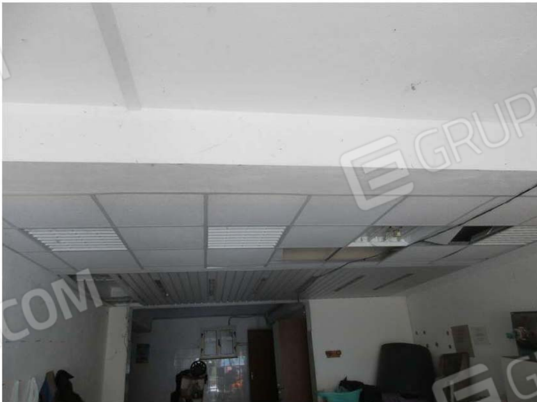
Foto 14: Particolare della controsoffittatura
