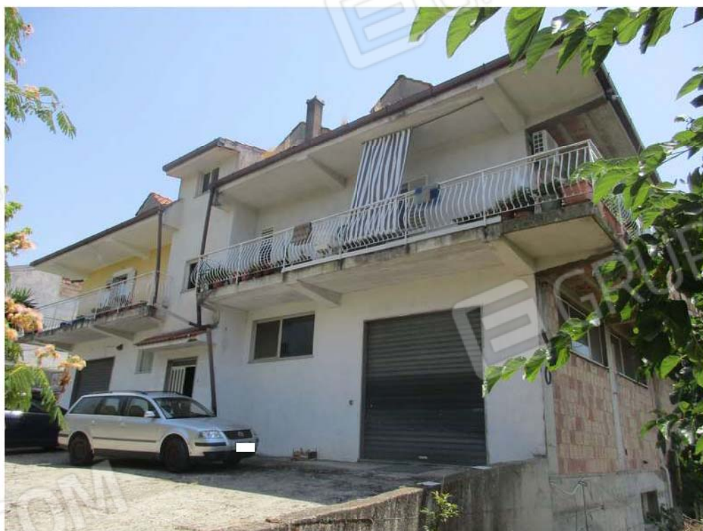
Foto 2: Vista sud ovest del fabbricato
