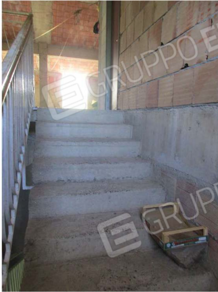
Foto 80: La rampa di scale di arrivo al sottotetto
