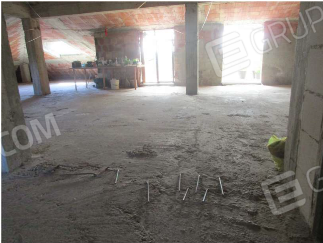
Foto 81: L'interno del sottotetto
