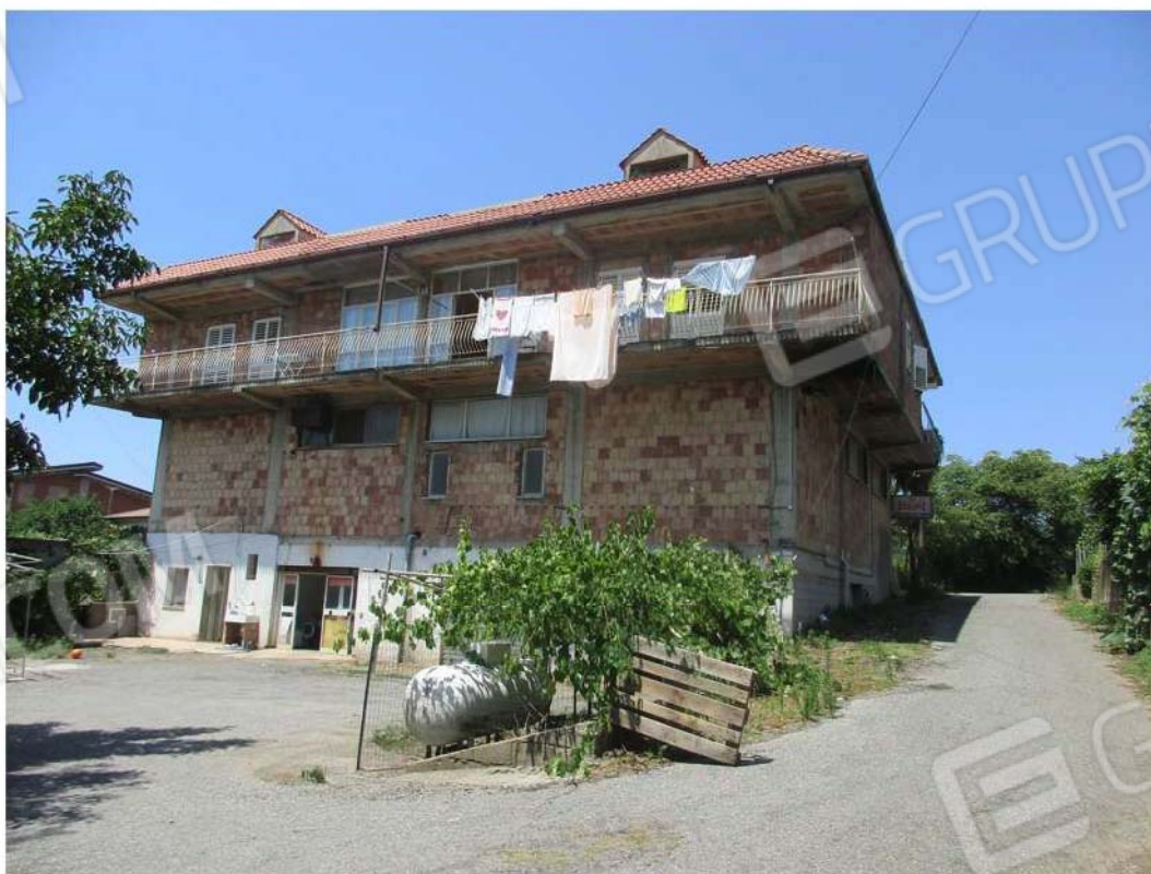
Foto 4: Prospetto est del fabbricato
