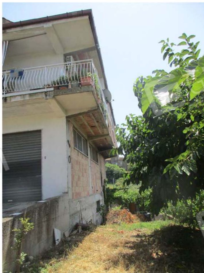
Foto 6: Il fronte Sud del fabbricato
