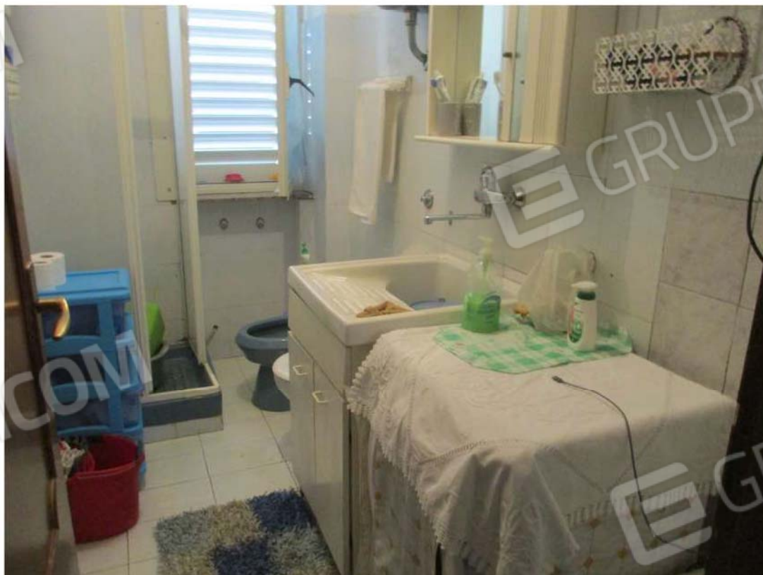
Foto 66: Particolare del servizio igienico
