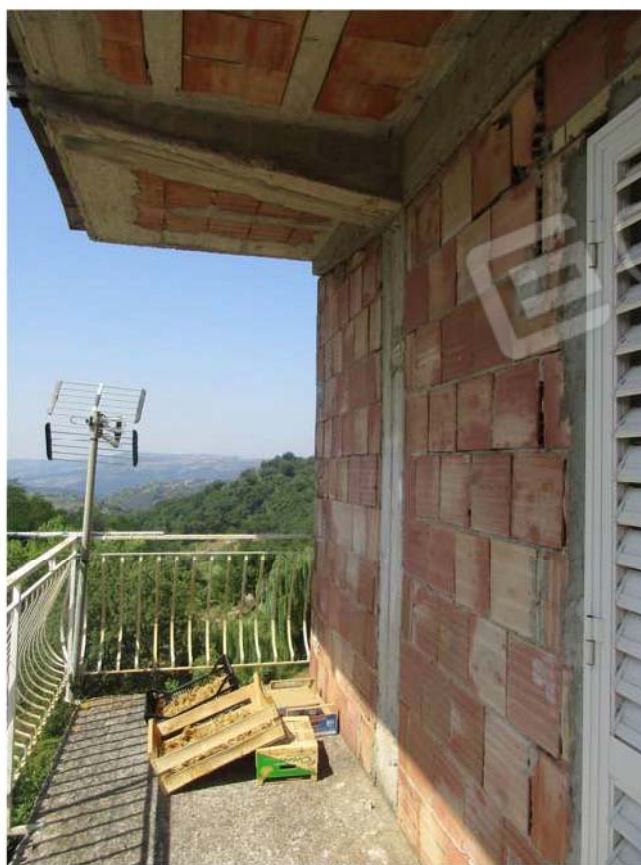
Foto 78: Il lato opposto del balcone di cui alla precedente foto
