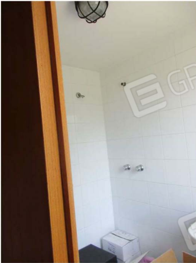
Foto 39: Scorcio del locale doccia
