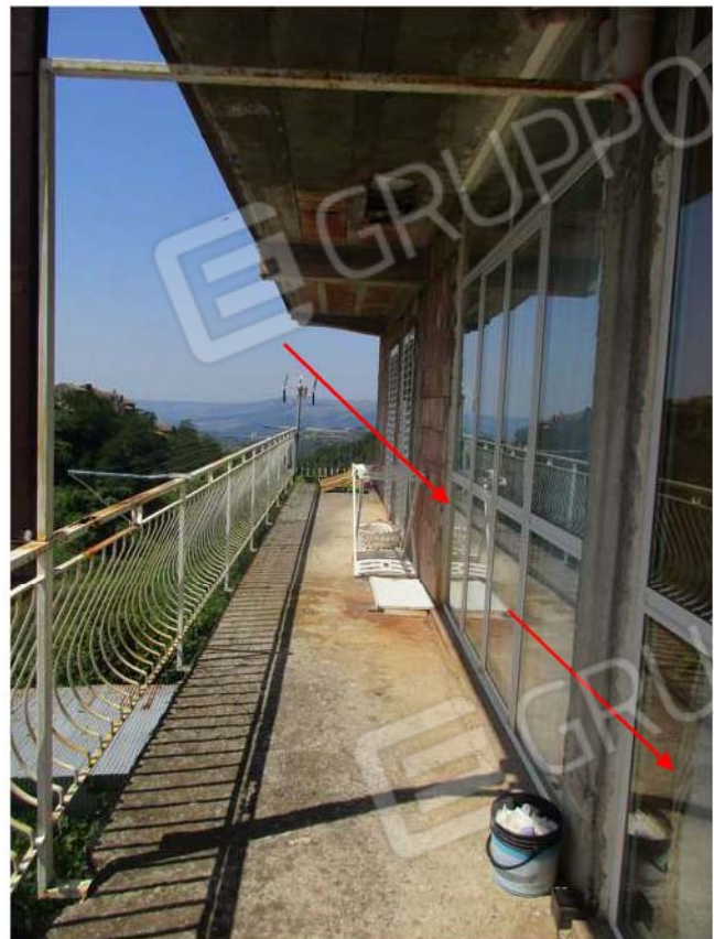
Foto 58: Il balcone sul fronte est: in evidenza le due vetrate con le quali è stata confinata l'area destinata a veranda
