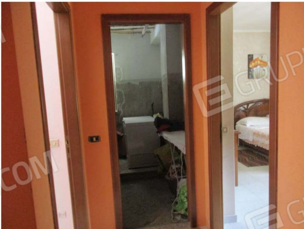
Foto 44: Vista dal disimpegno sulle stanze – di fronte il servizio igienico non ultimato
