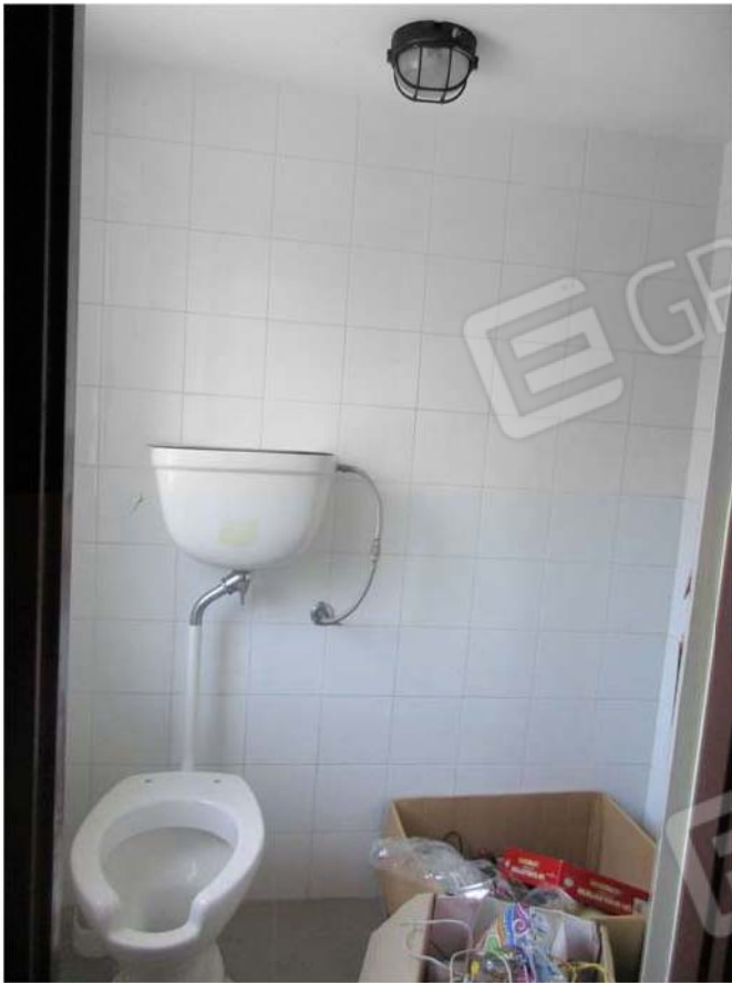
Foto 37: Vista del servizio igienico
