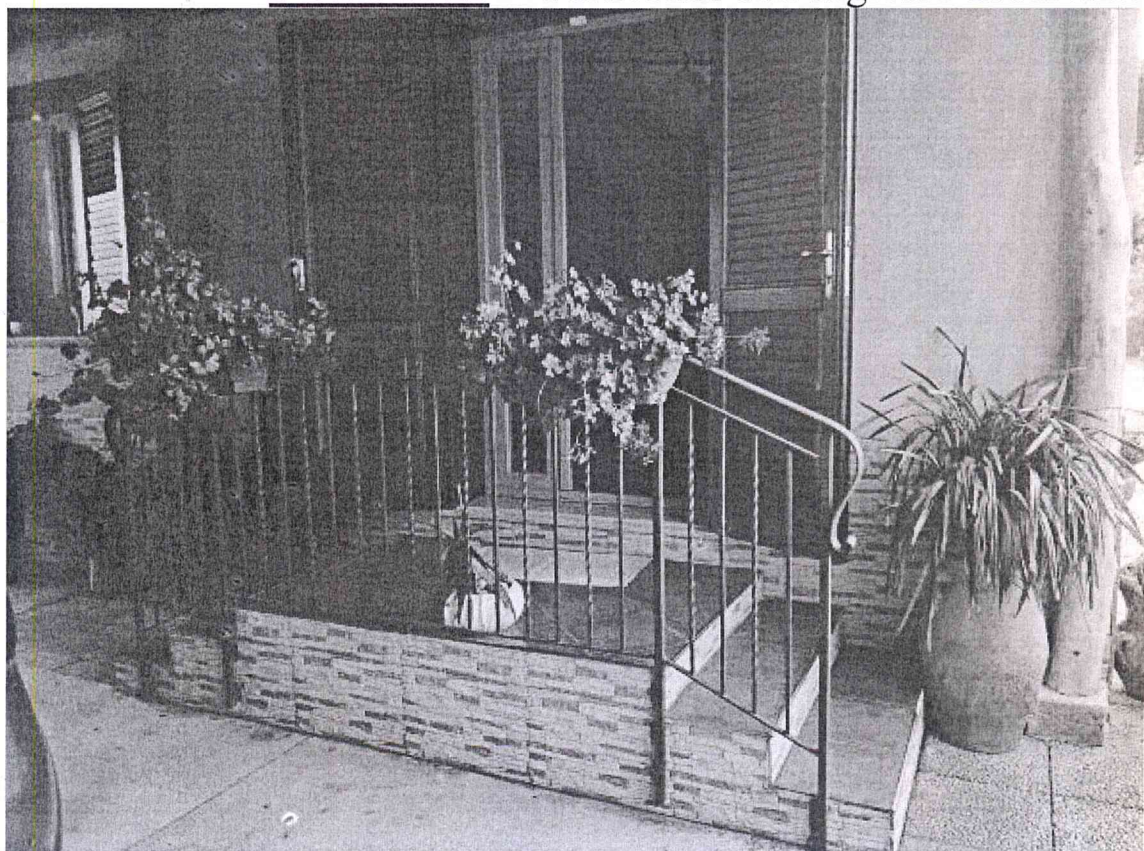
FOTO n. 22 Particolari dell'ingresso di servizio
