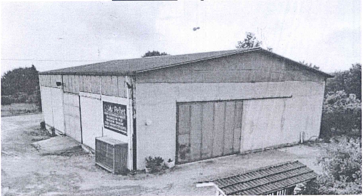
FOTO n. 4 Il capannone visto nel suo insieme
