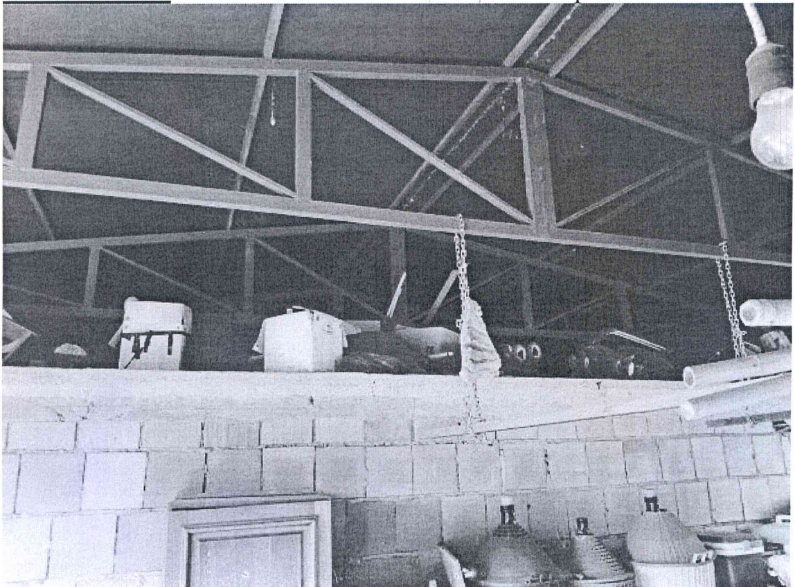
FOTO n. 11 Particolare del tetto nella zona deposito
