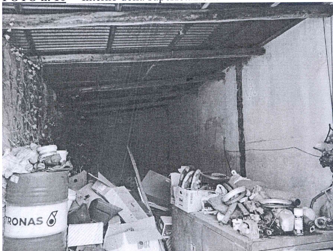
FOTO n. 10 Interno della superfetazione
