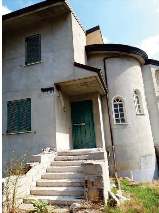
LOTTO 005a – Ingresso dell’abitazione
