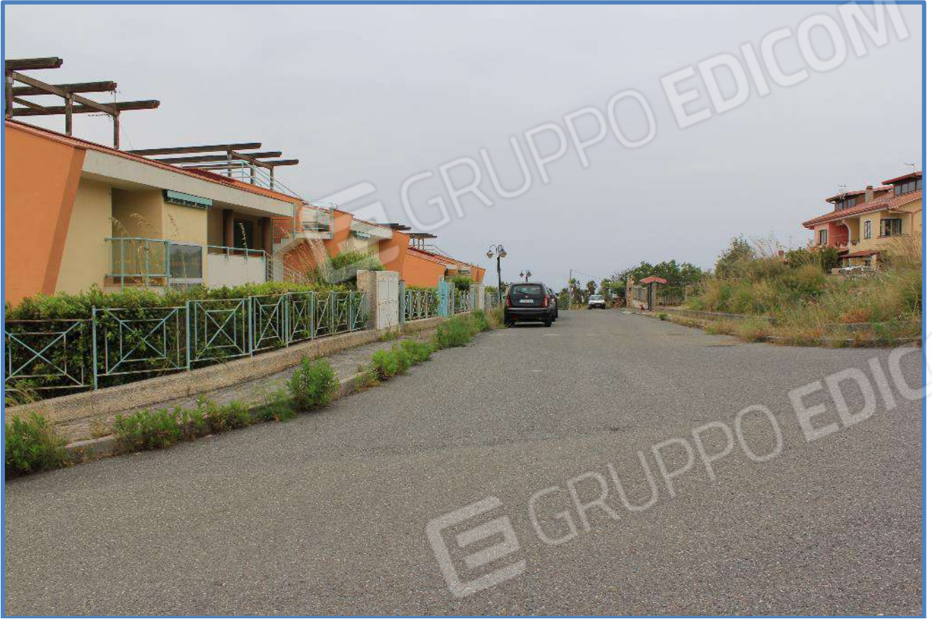
0.13- Strada di lottizzazione – lato N/E
