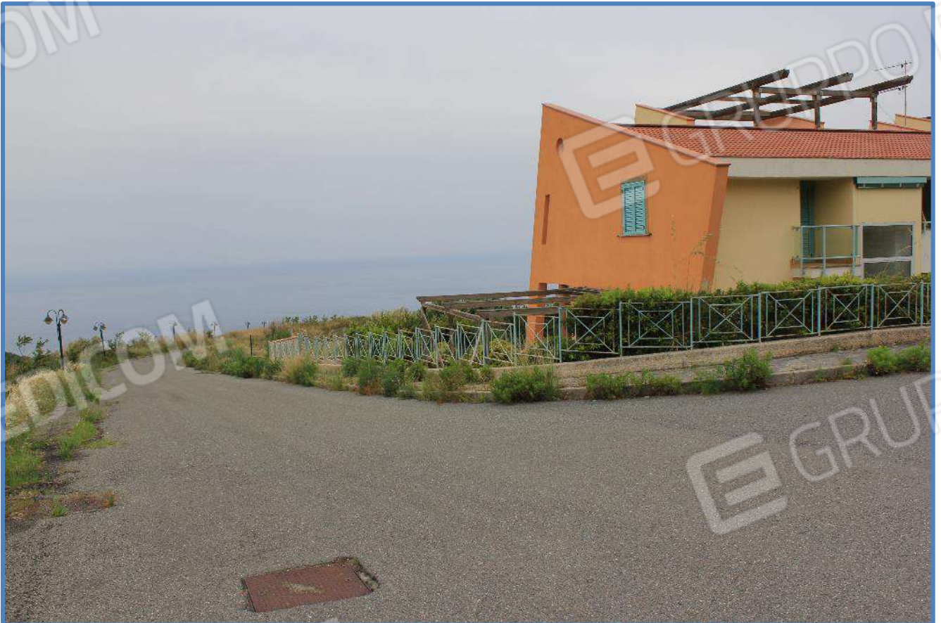
0.14- Strada di lottizzazione – lato S/E
