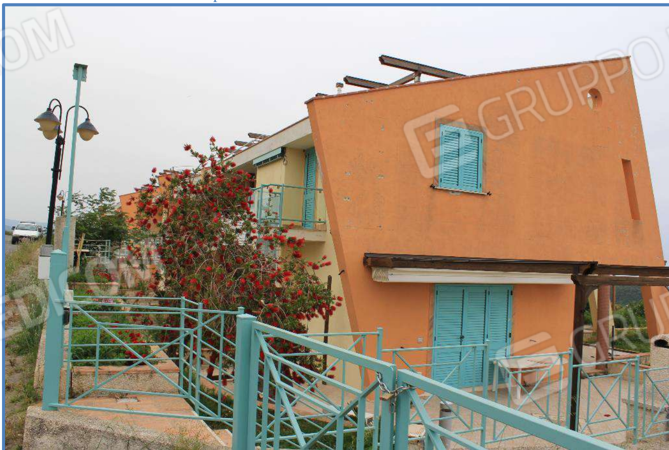
0.12- Fabbricato individuato con particella n. 733
