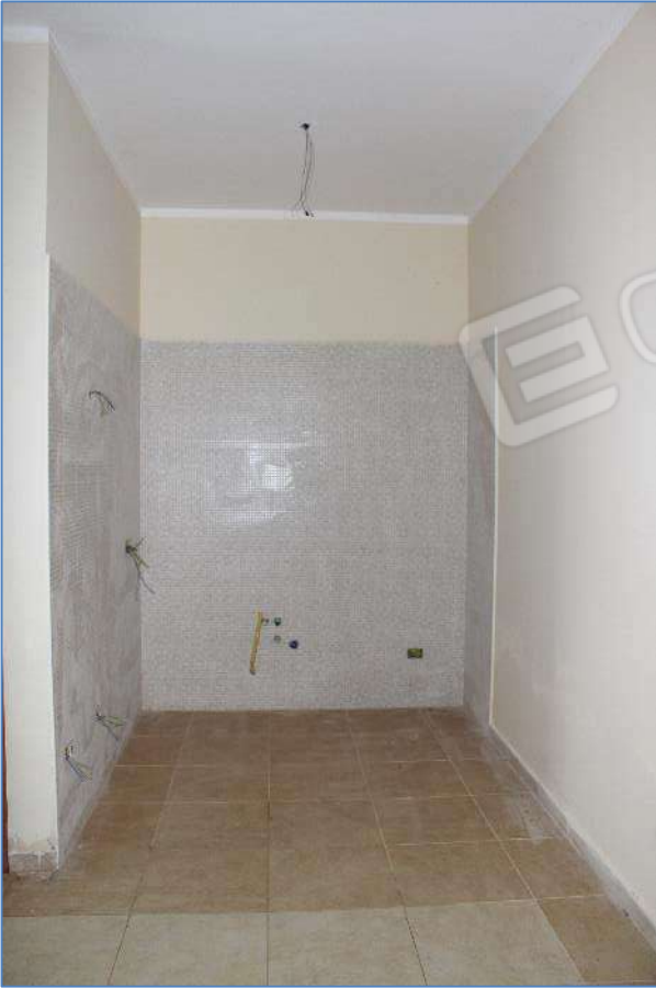
7.5, 7.6- Zona giorno – Angolo cottura e locale WC
