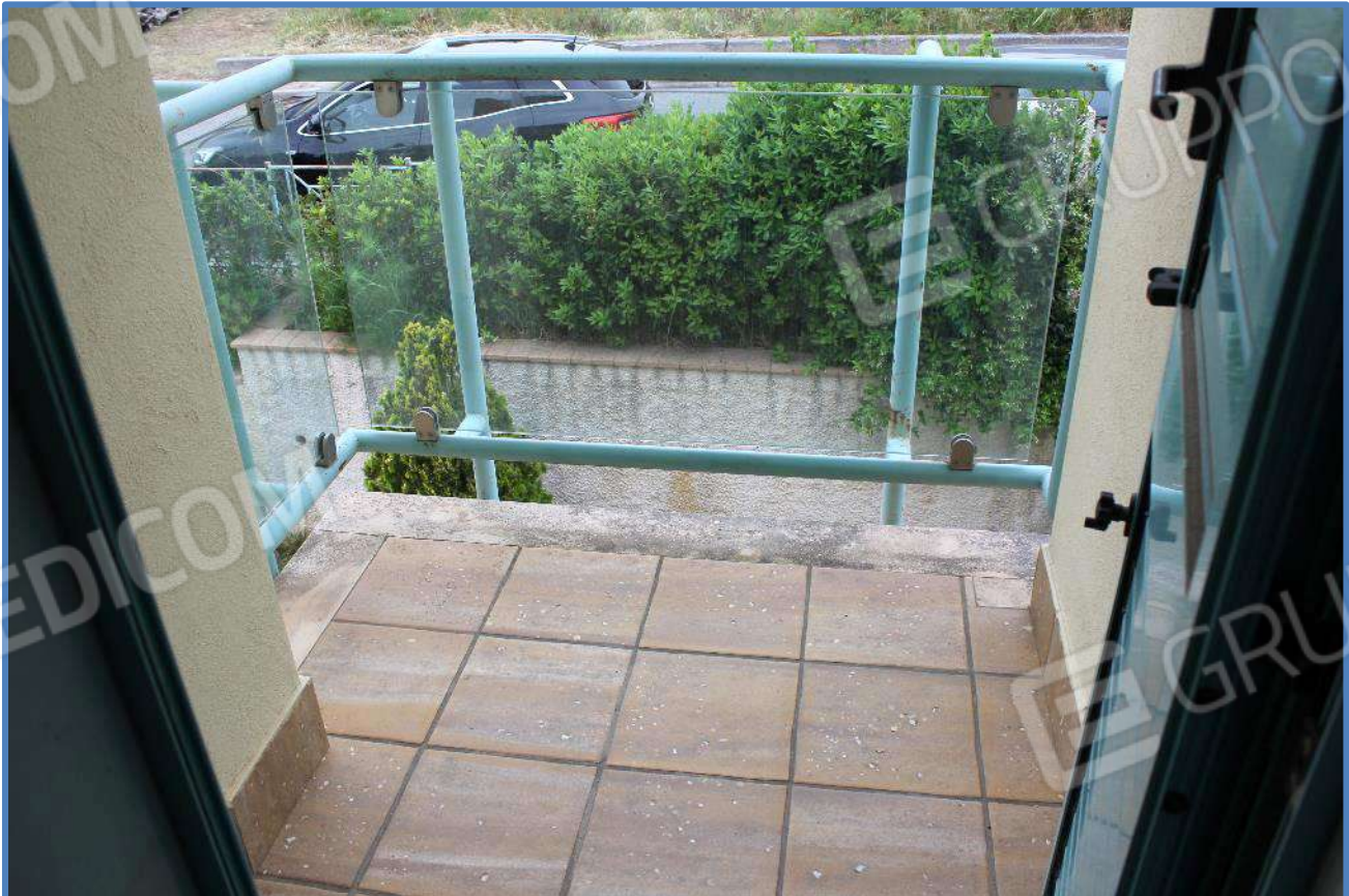
5.17- Zona notte – Balcone prospiciente il Locale WC
