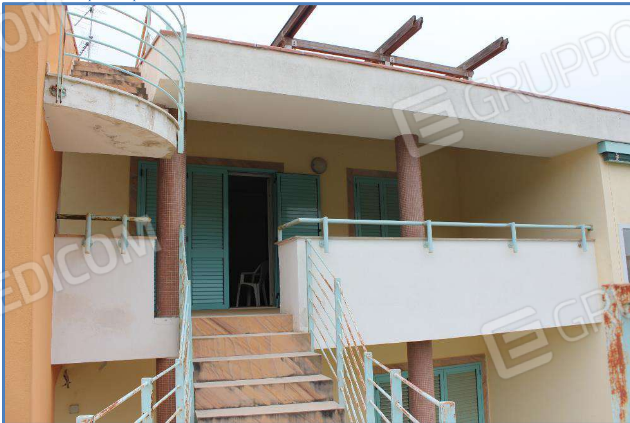
2.2- scaletta e portico pertinenziale d'accesso all'abitazione
