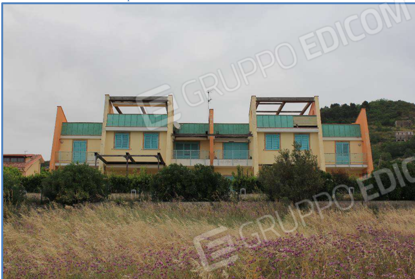
0.7- Fabbricato individuato con particella n. 734
