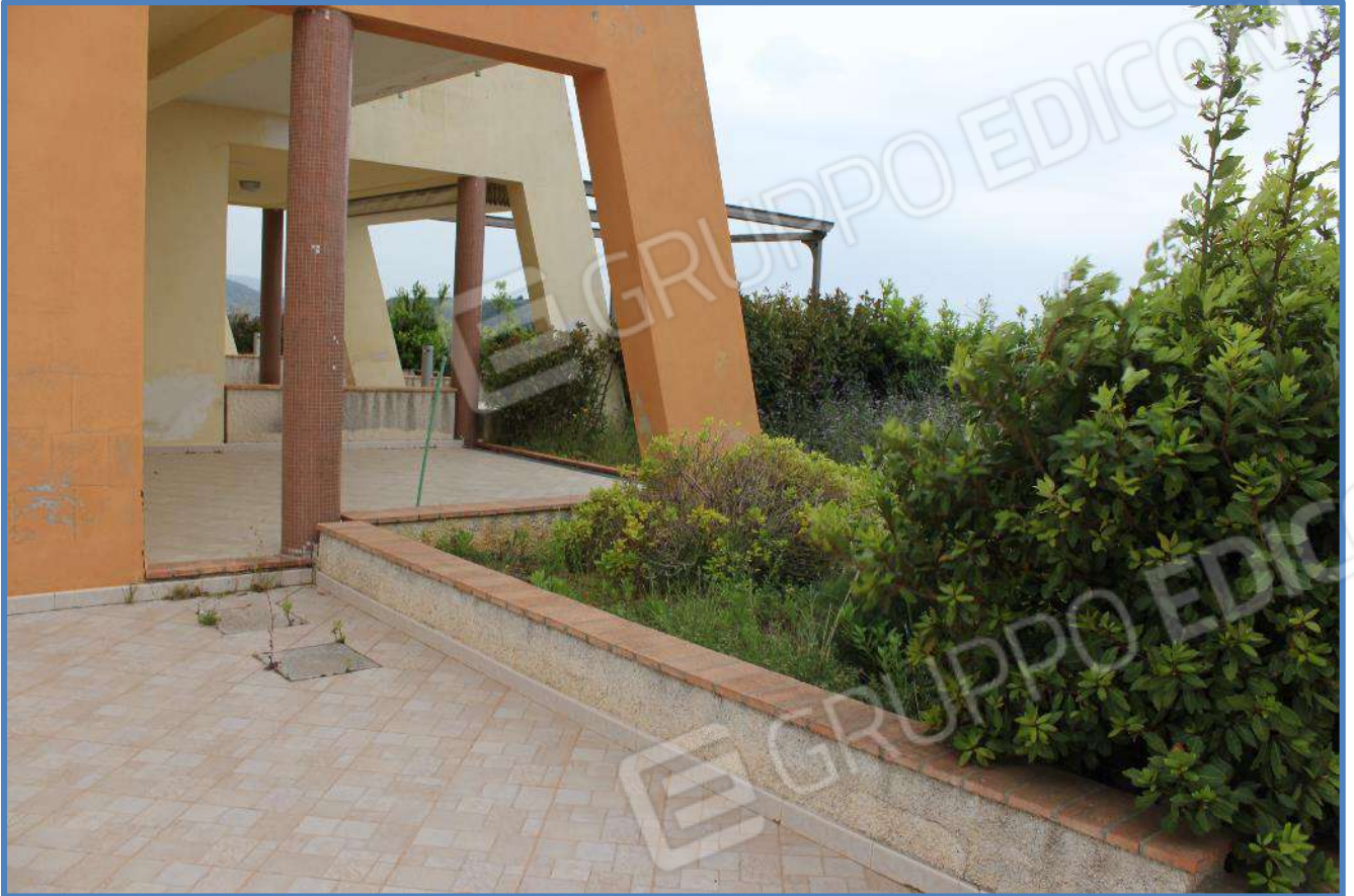
5.5- Corte e giardino di Pertinenza Esclusiva, che accede all'abitazione (p.lle 731/14 – 731/5)
