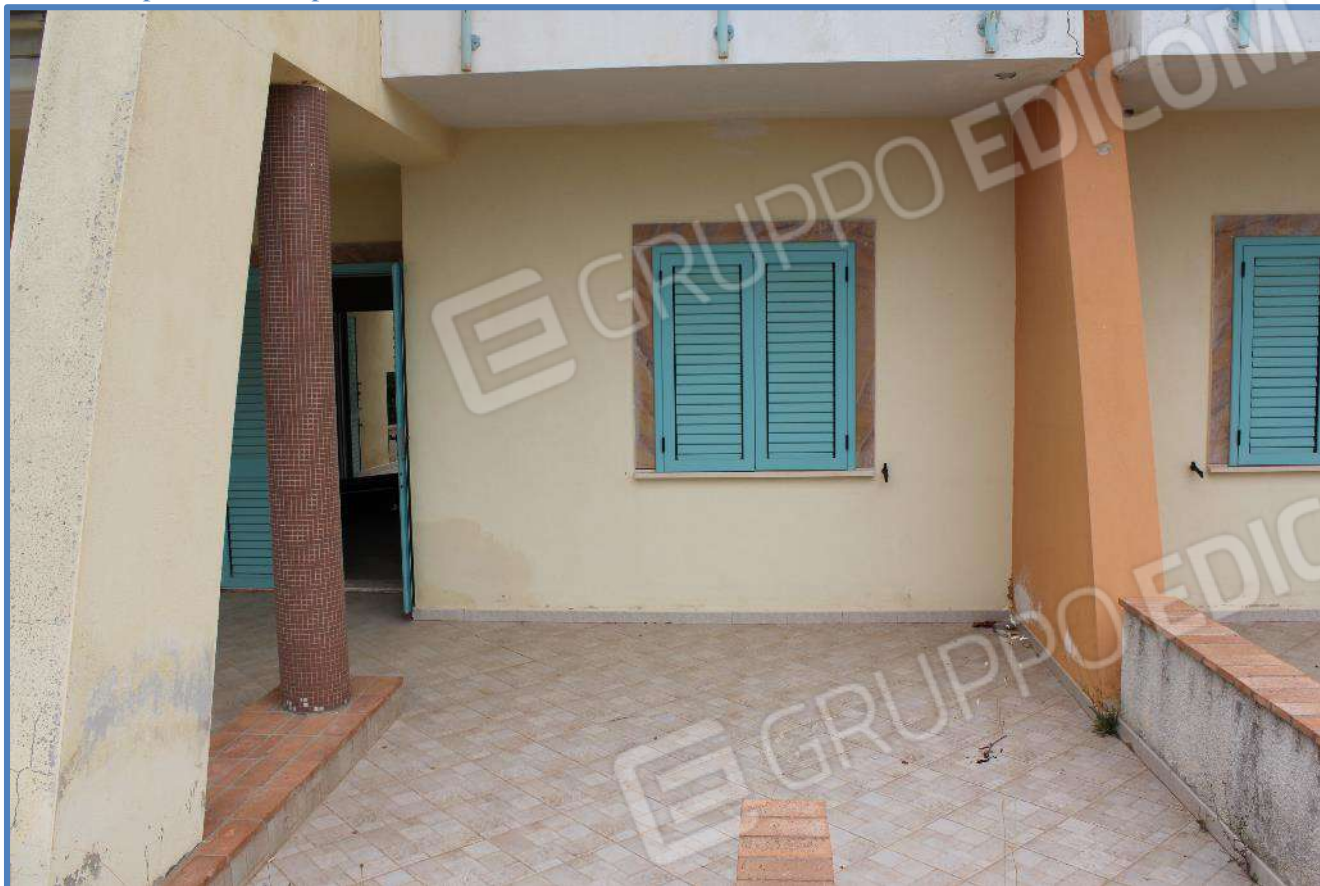
1.17- Corte pertinenziale (p.Ila 731/19)
