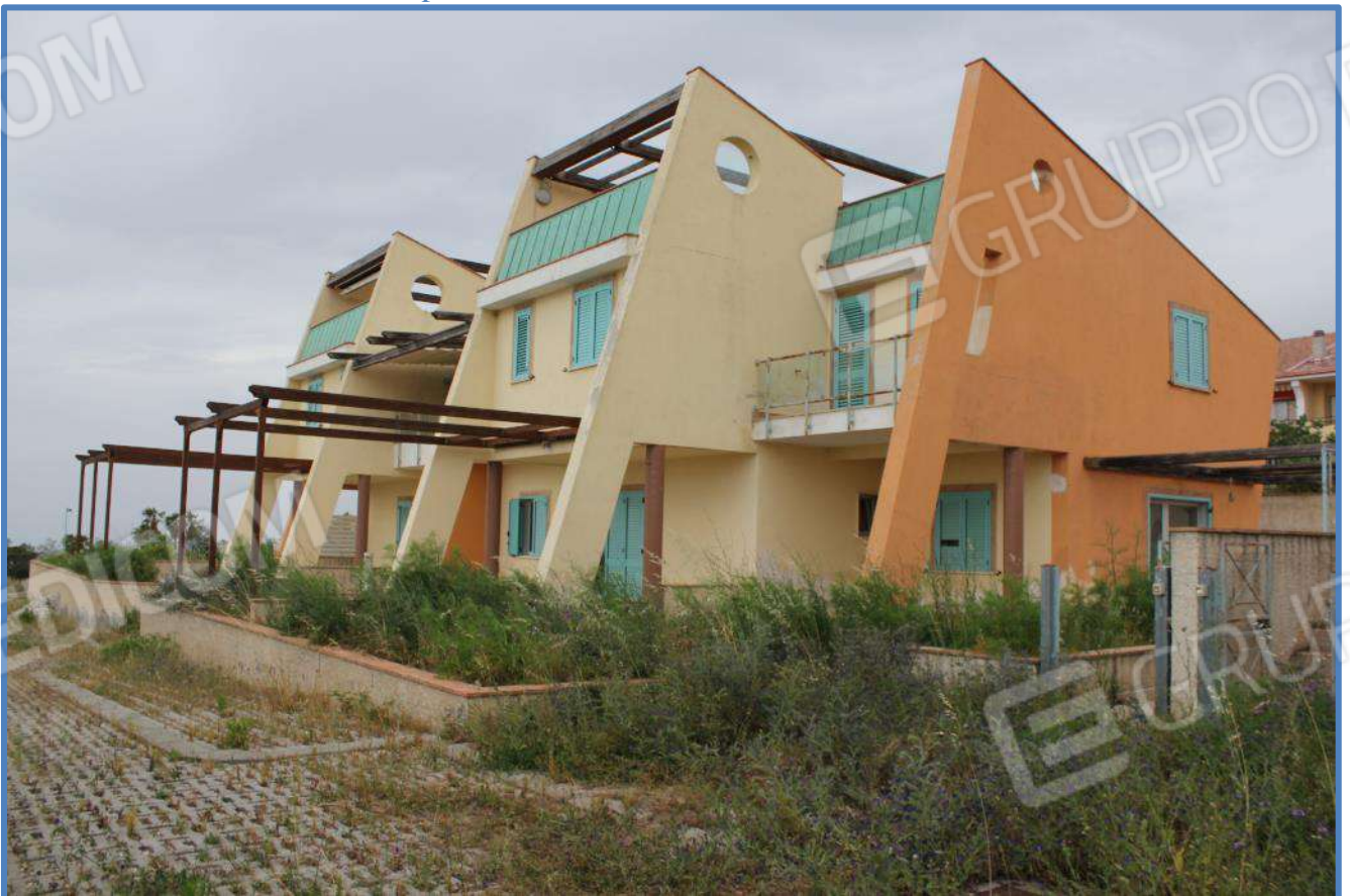
0.10- Fabbricato individuato con particella n. 733
