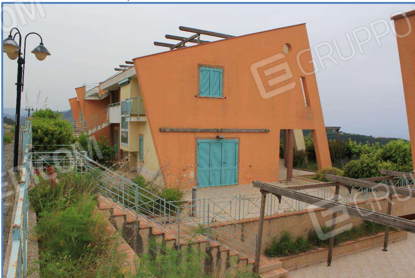
0.8- Fabbricato individuato con particella n. 734
