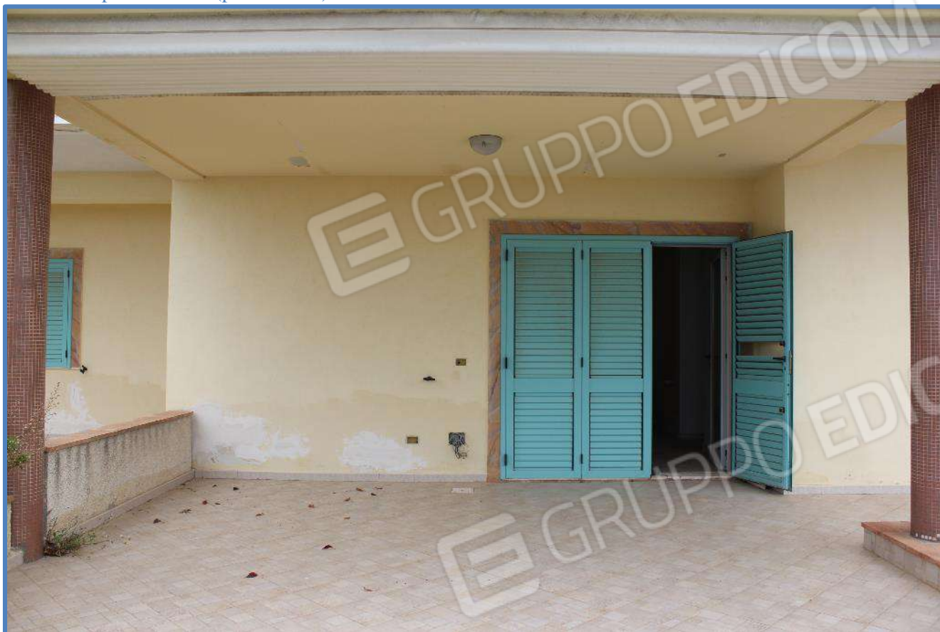
1.15- Corte pertinenziale (p.Ila 731/19)
