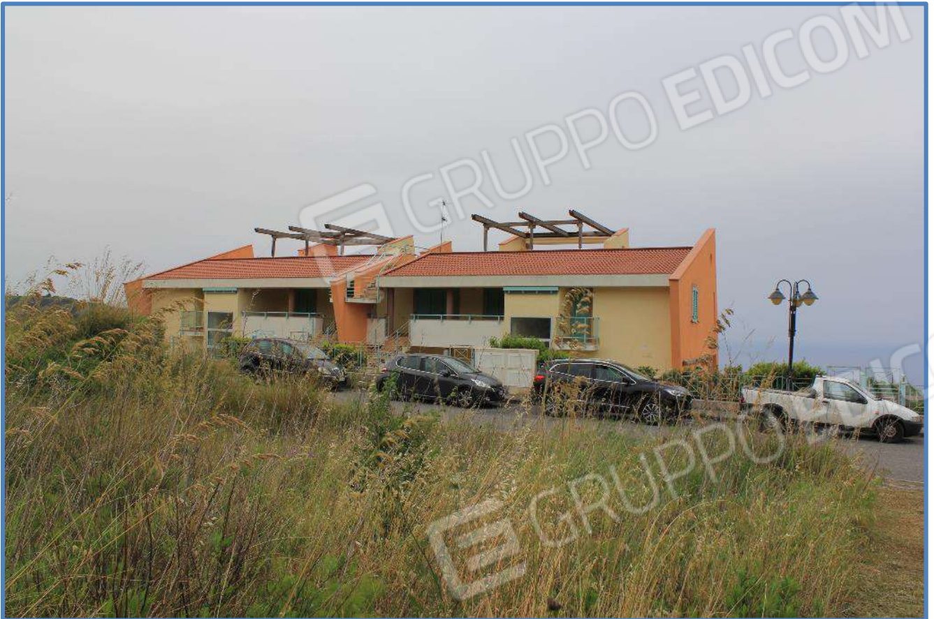
0.9- Fabbricato individuato con particella n. 733
