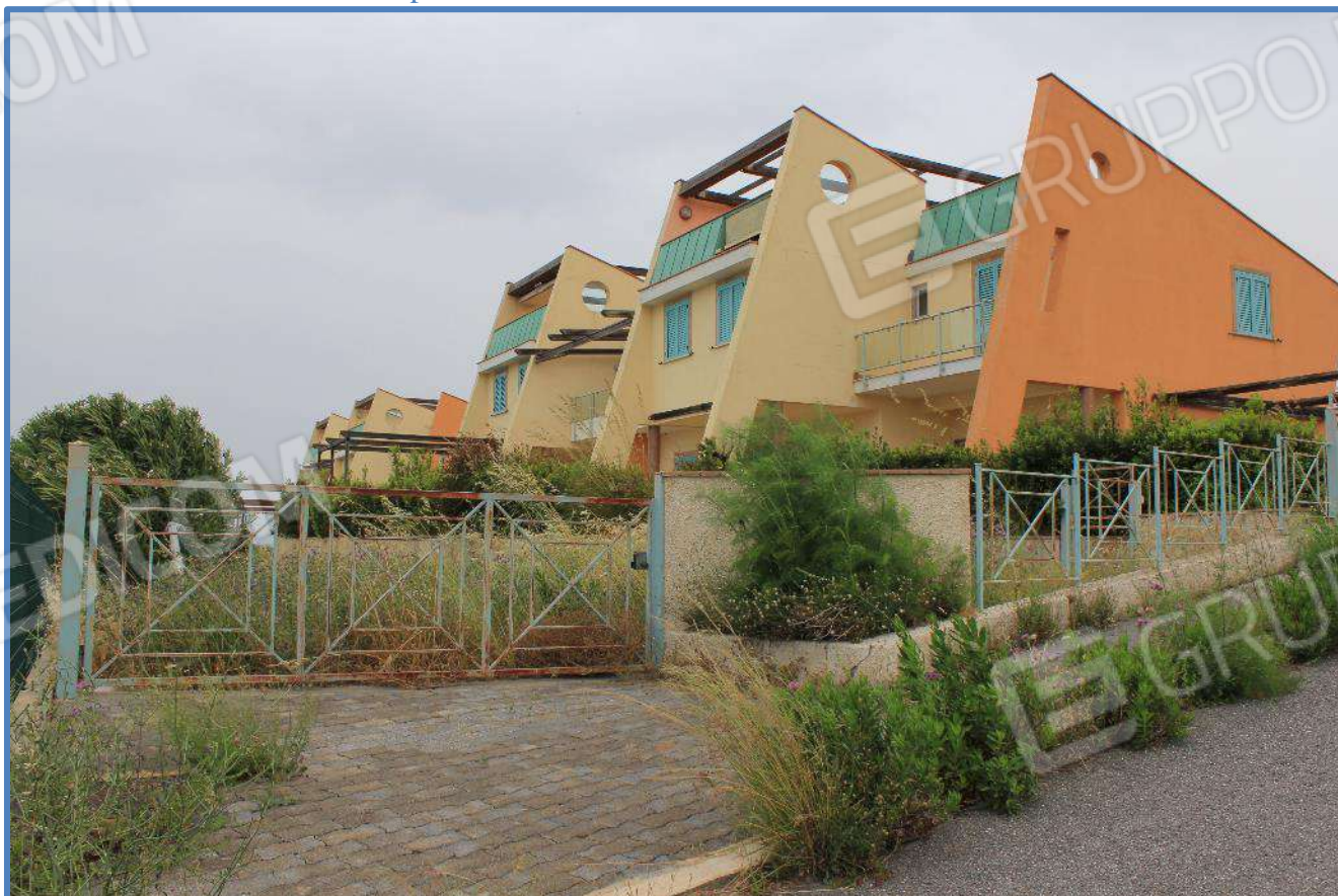
0.6- Fabbricato individuato con particella n. 734
