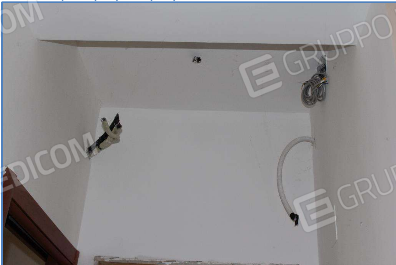
1.14- Particolare presenza predisposizioni per impianti
