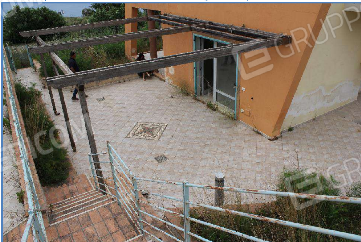
4.3- corte di pertinenza esclusiva che accede all'abitazione (p.lla 731/14)
