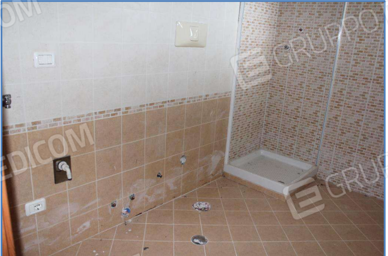
7.7- Zona giorno – Locale WC
