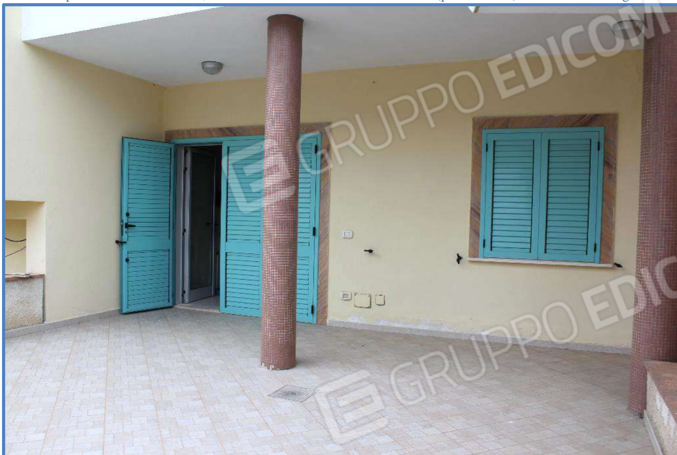
6.3- Corte pertinenziale esclusiva, che consente l'accesso all'abitazione (p.lla 731/12) – vista verso l'ingresso
