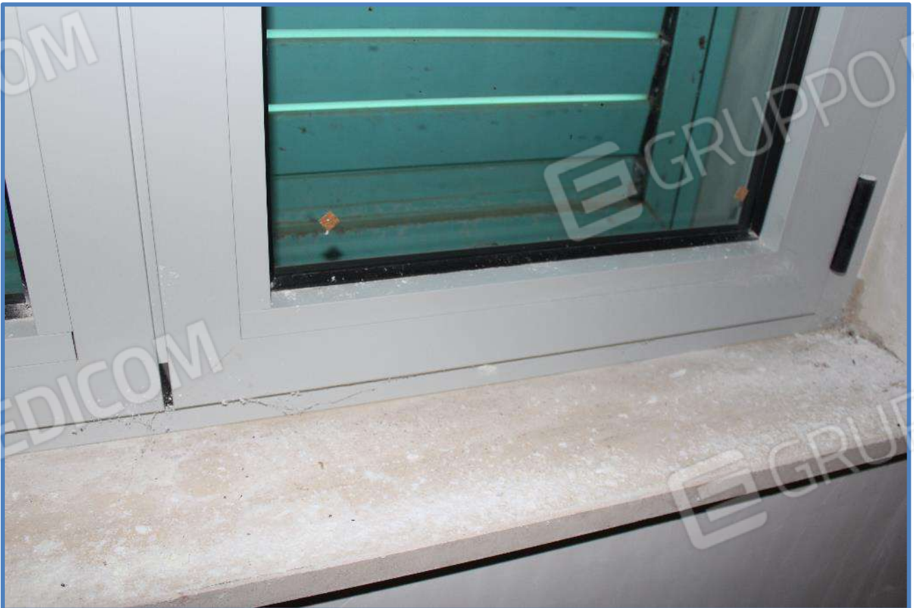
8.23- Zona notte – Camera – Particolare materiali infissi e davanzale
