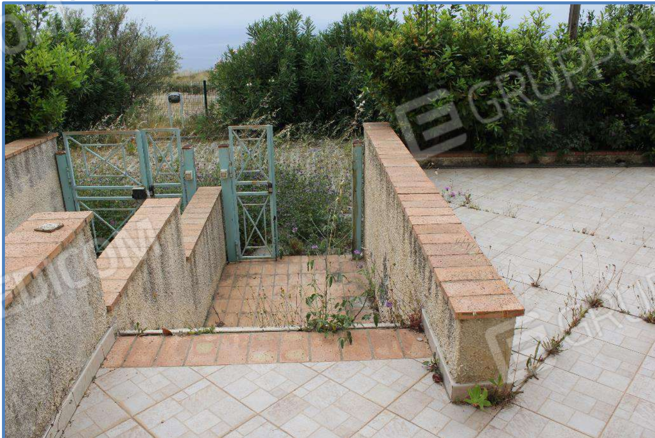
1.18- Corte pertinenziale (p.Ila 731/19) – vista su scala d’accesso lato opposto
