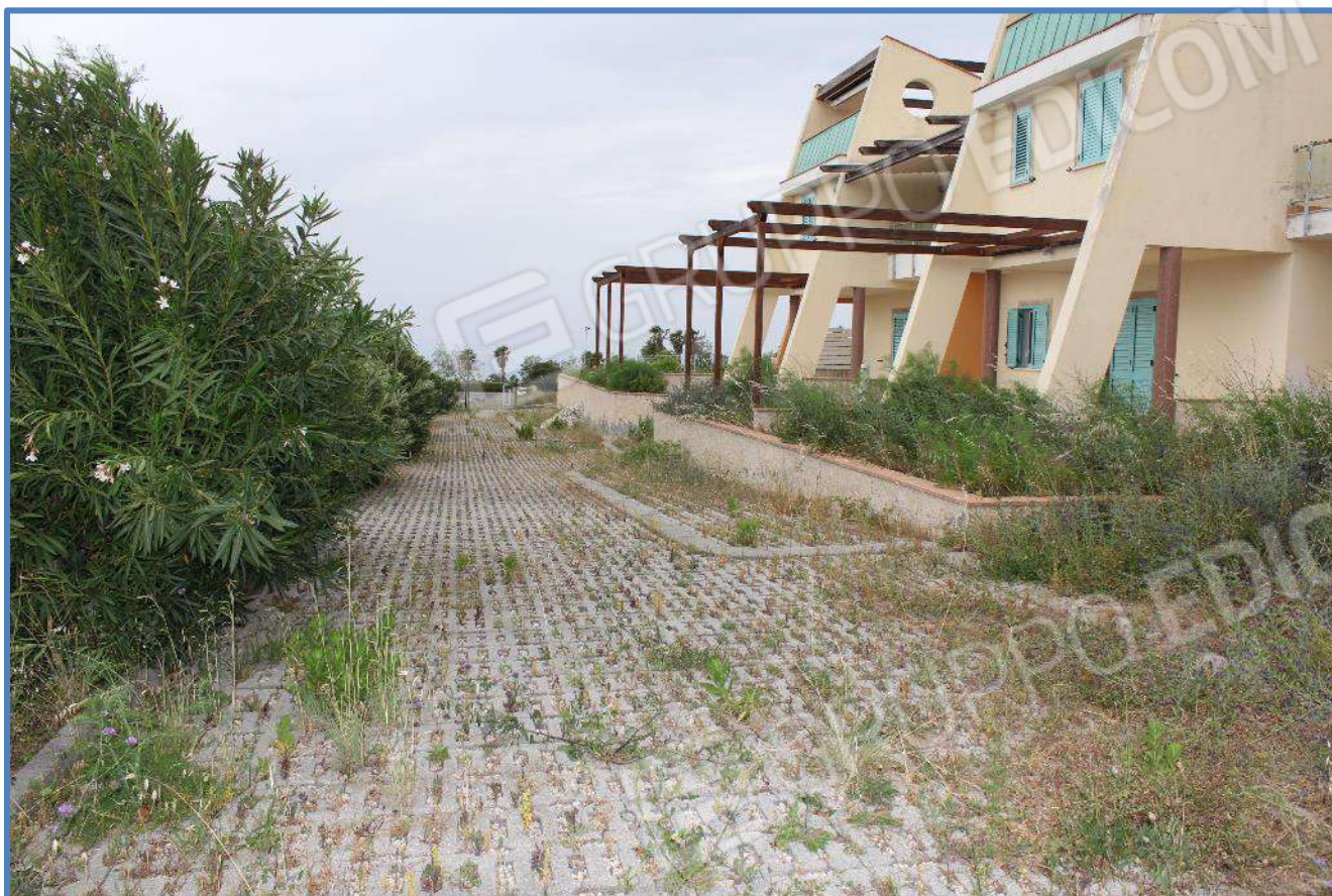
0.15- Corte di accesso ai fabbricati – lato S/O
