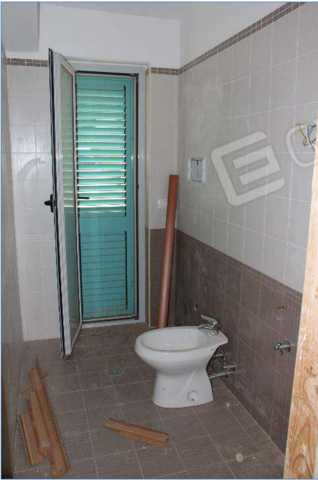
4.23, 4.24- Zona notte – Locale WC
