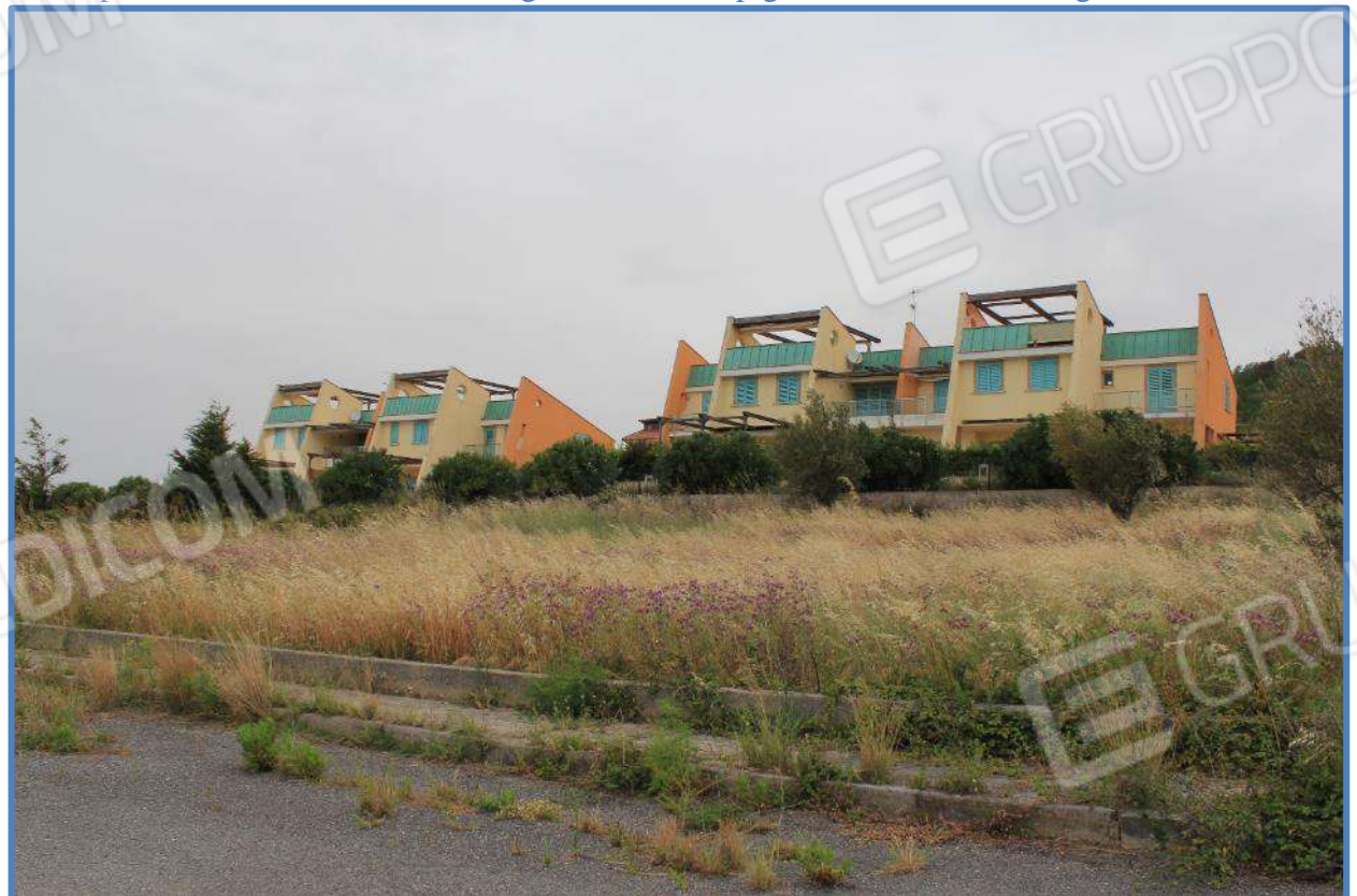
0.4- Complesso edilizio in cui ricadono gli immobili in pignoramento – Vista angolo Sud
