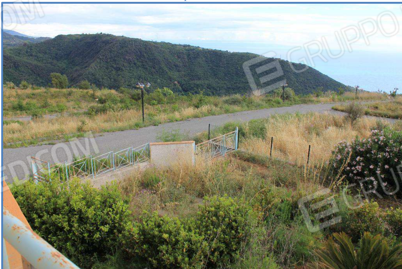
0.16- Strada di lottizzazione – lato S/E – Vista panoramica
