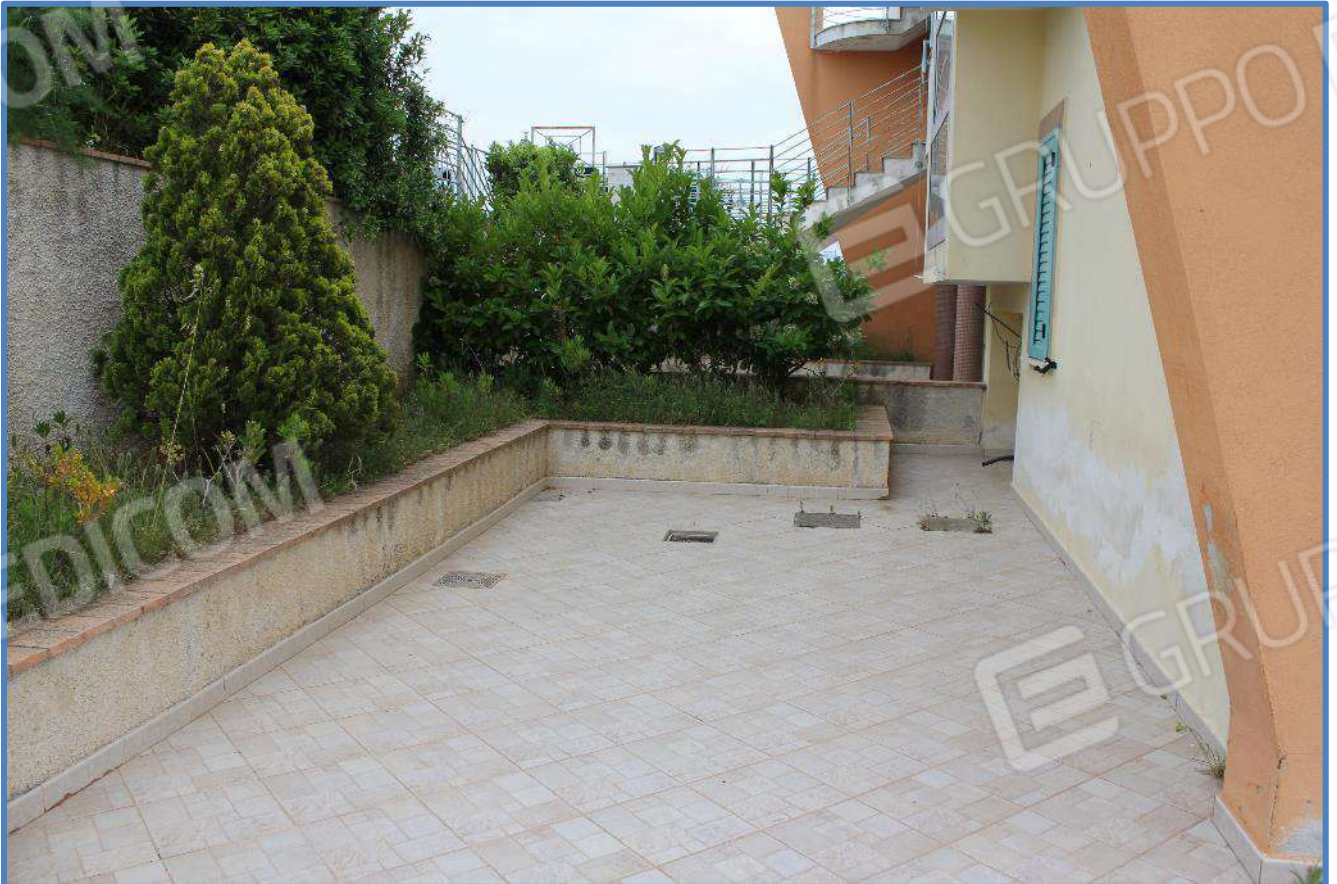
5.4- Corte di Pertinenza Esclusiva, che accede all’abitazione (p.IIa 731/14)
