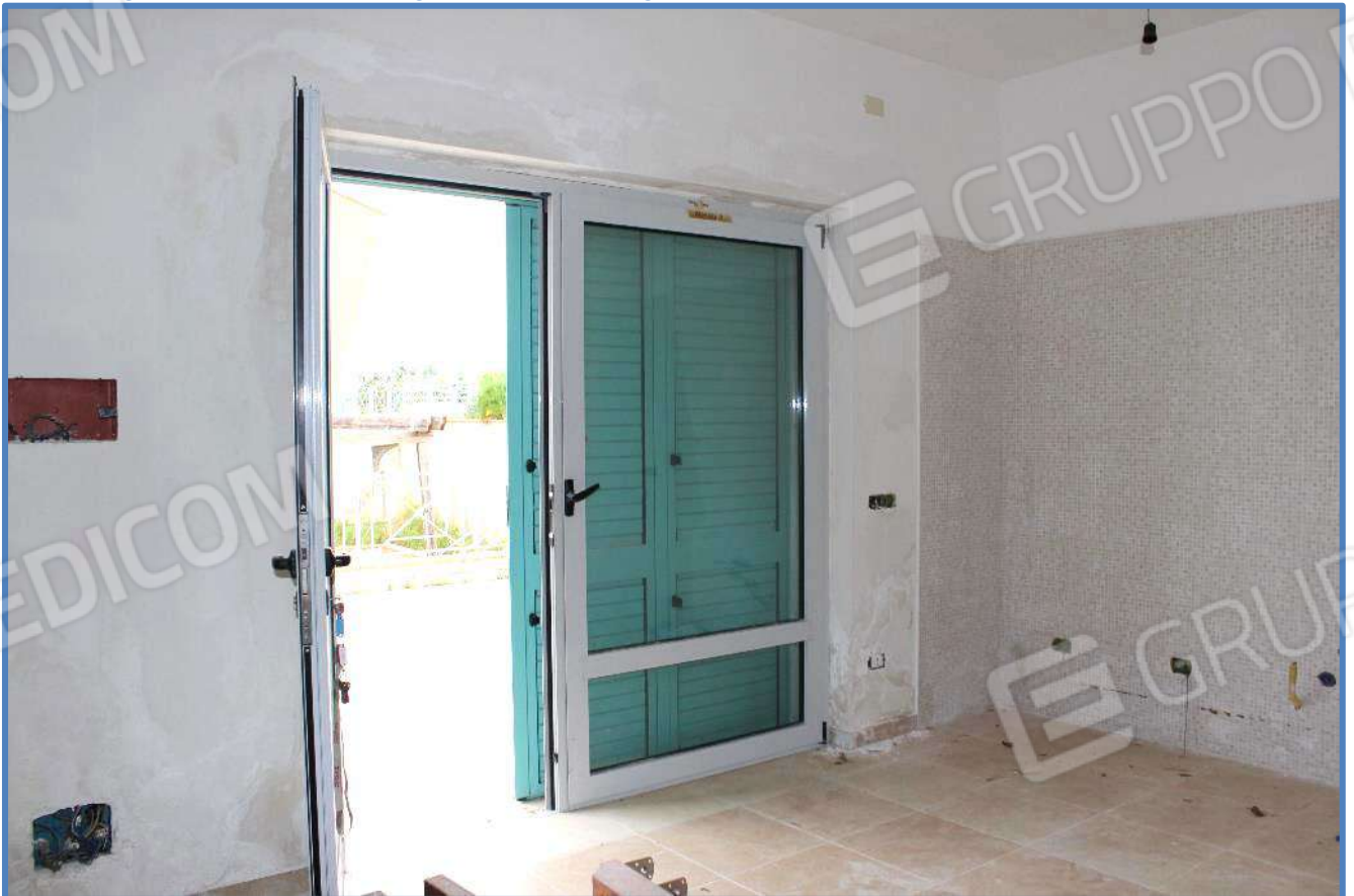
5.8- Zona giorno – Vista verso l’ingresso – visibile angolo cottura
