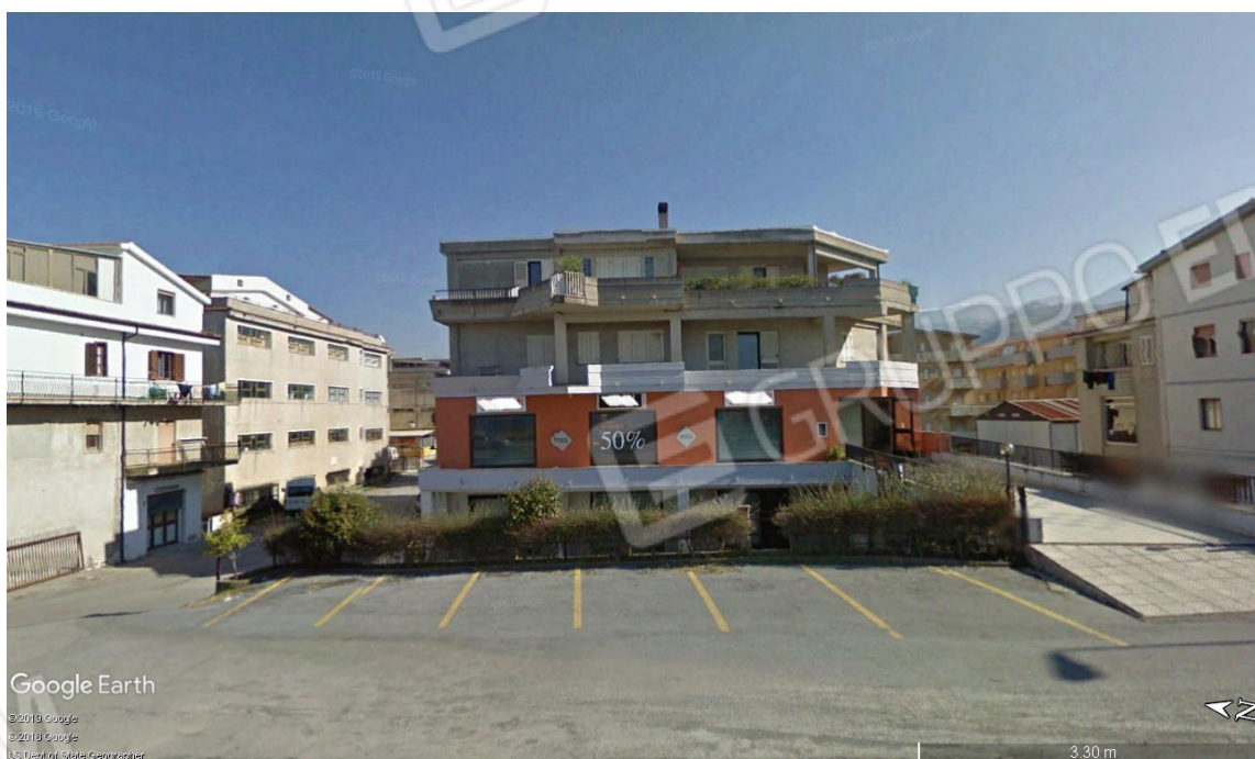
Foto 1 – Ripresa lato ovest
