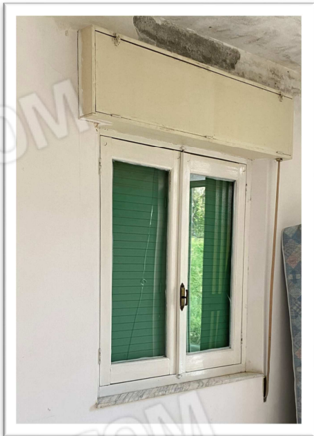
FOTO 27 – INFISSO IN LEGNO CON TAPPARELLA IN PVC
