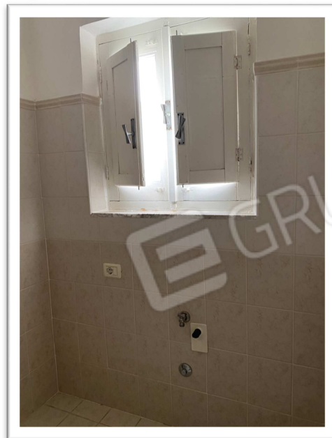
FOTO 28 – INFISSO IN LEGNO CON SCURI IN LEGNO
