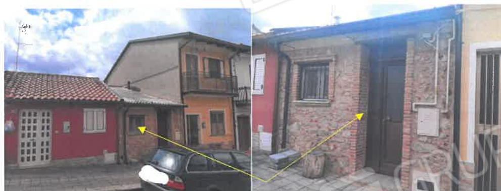
Figura 1: Prospetto principale immobile ubicato al n. 96 in Monsoreto di Dinami (VV)
