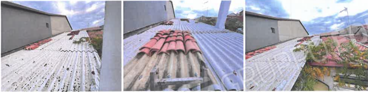
Foto 9-14: Vano sottotetto e tetto
