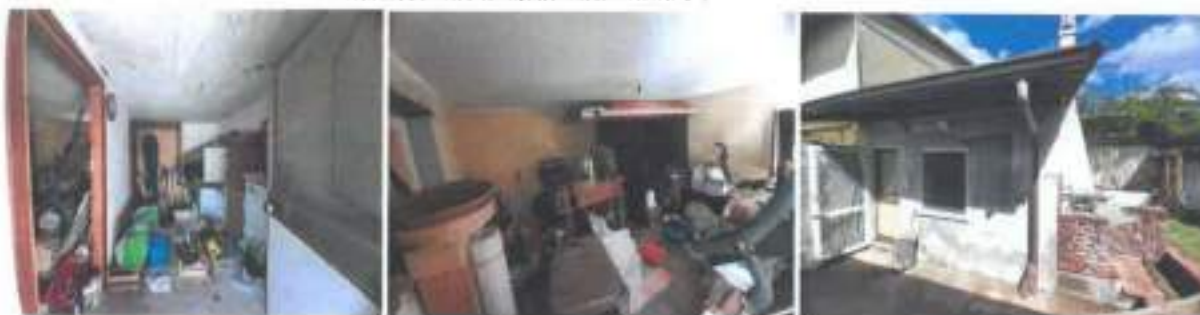
Foto 15-26: Giardino con Fabbricato (magazzino) e legnaia.
