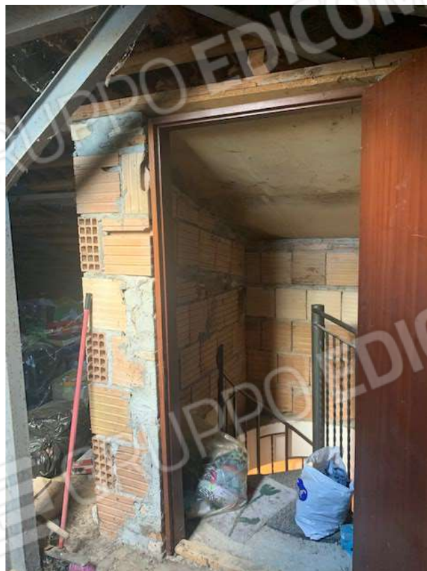
Foto 27-28-29-30 - Vista scala interna che conduce nel sottotetto realizzata in difformità al progetto relativo alla Concessione Edilizia n.12/06, così come riportato nella planimetria dello stato di fatto (Allegato 8).
