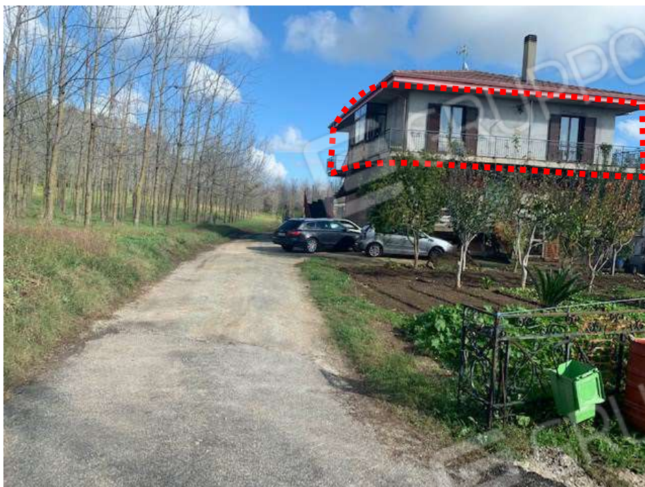
Foto 1 – Vista SW Panoramica immobile dalla SP88 [red dashed box] = unità abitativa oggetto di causa collocata al 1° piano.
