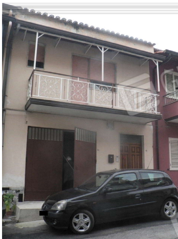
Foto 1 e 2 - Viste del Fabbricato su due piani fuori terra
