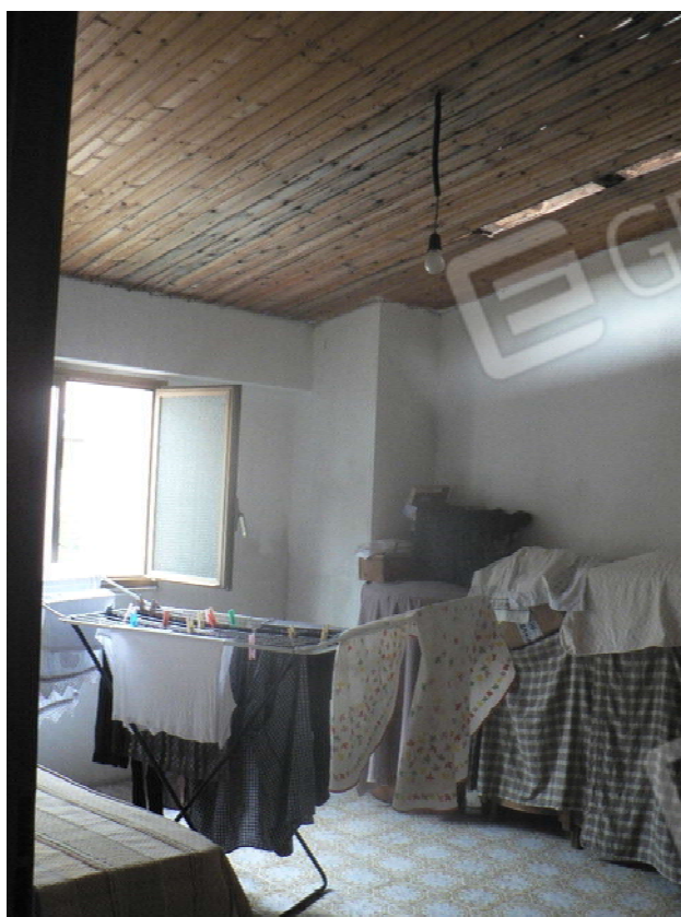
Foto 18 – Vista Deposito, zona Notte
