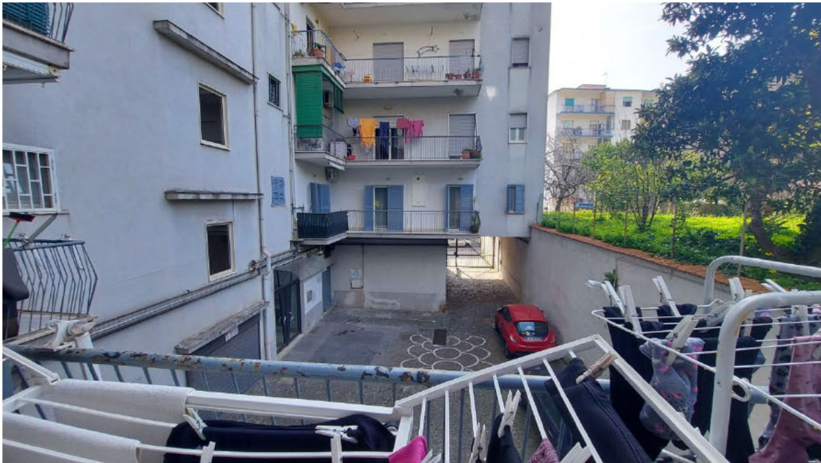
balcone BL1 - affaccio su cortile condominiale lato via F. Bottazzi
