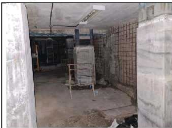
foto 46 – consolidamento delle pareti con rete metallica NON portato a termine.
