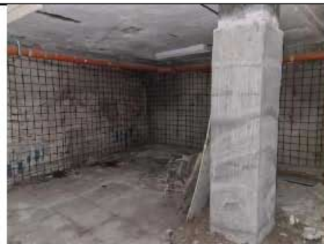
foto 46 – consolidamento delle pareti con rete metallica NON portato a termine.
