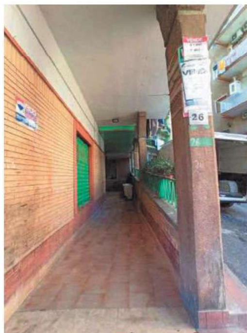
Corridoio ingresso Edificio
