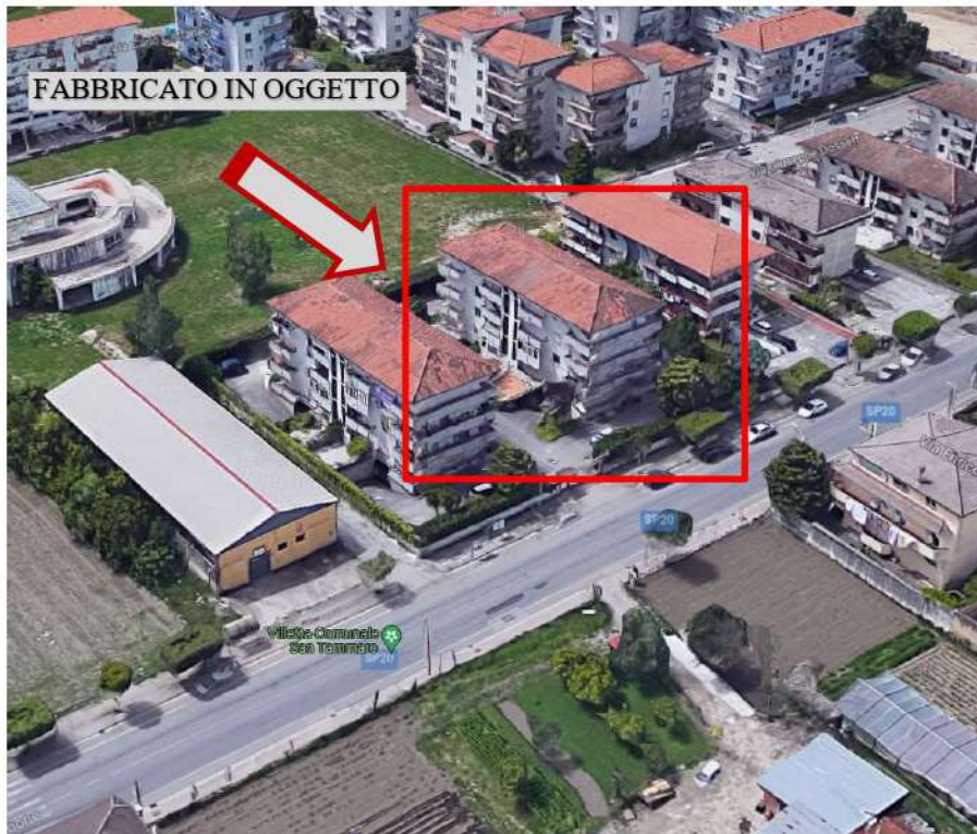
Figura 2 – Foto satellitare con indicazione fabbricato in oggetto
