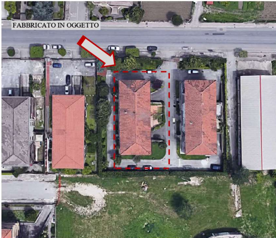
Figura 1 - Foto Satellitare con indicazione fabbricato in oggetto
