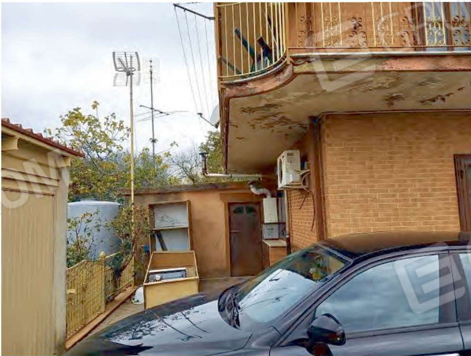
FOTO N. 6 – Vista del cortile pertinenziale lato Sud
