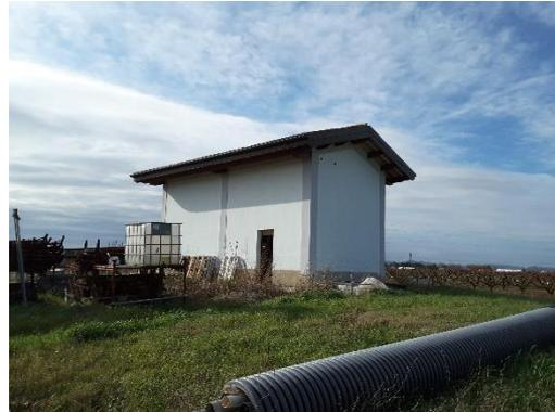
Alla data del sopralluogo è stato accertato che il deposito per il quale è stato rilasciato Permesso di Costruire n°158 del 2013, oltretutto scaduto per decorrenza dei termini di validità, non era completato. Mancavano parte dei tamponamenti interni in legno; la pavimentazione e l'impianto elettrico.
