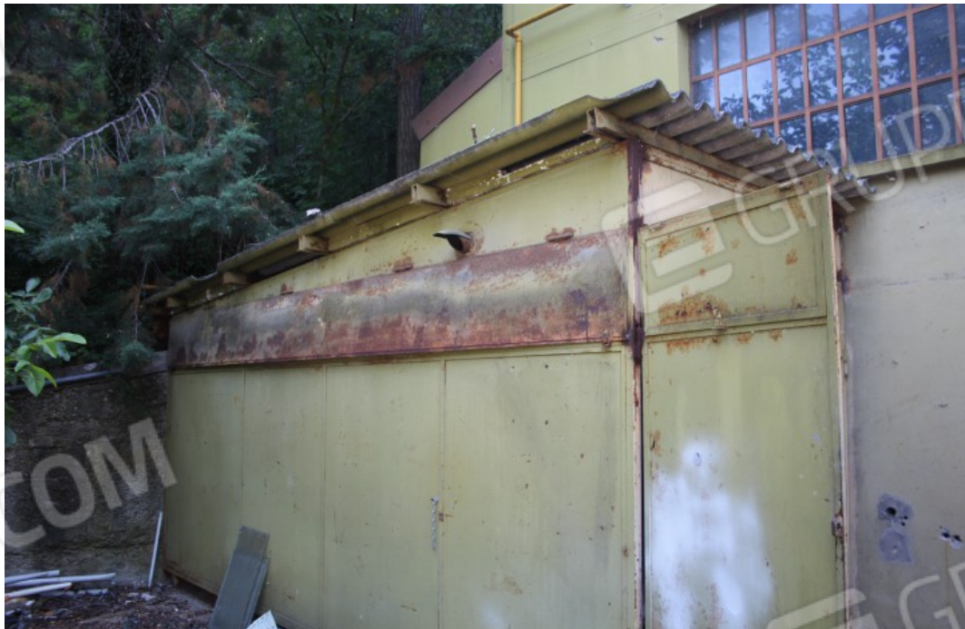
manufatto in lamiera fronte strada
